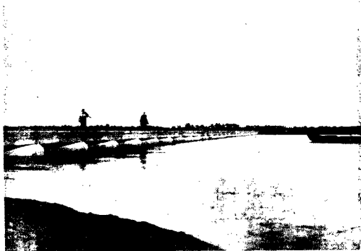
沂河橋長四里餘民 國二十三年山東 建設廳爲台高灘 汽車路建
