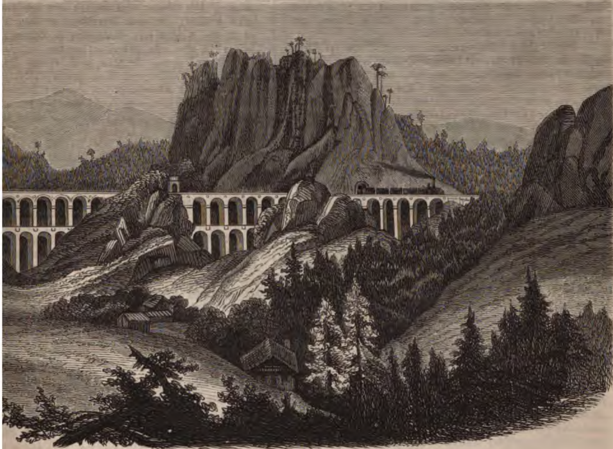
Ein Stück der Semmering-Bahn am Brettenstein.
