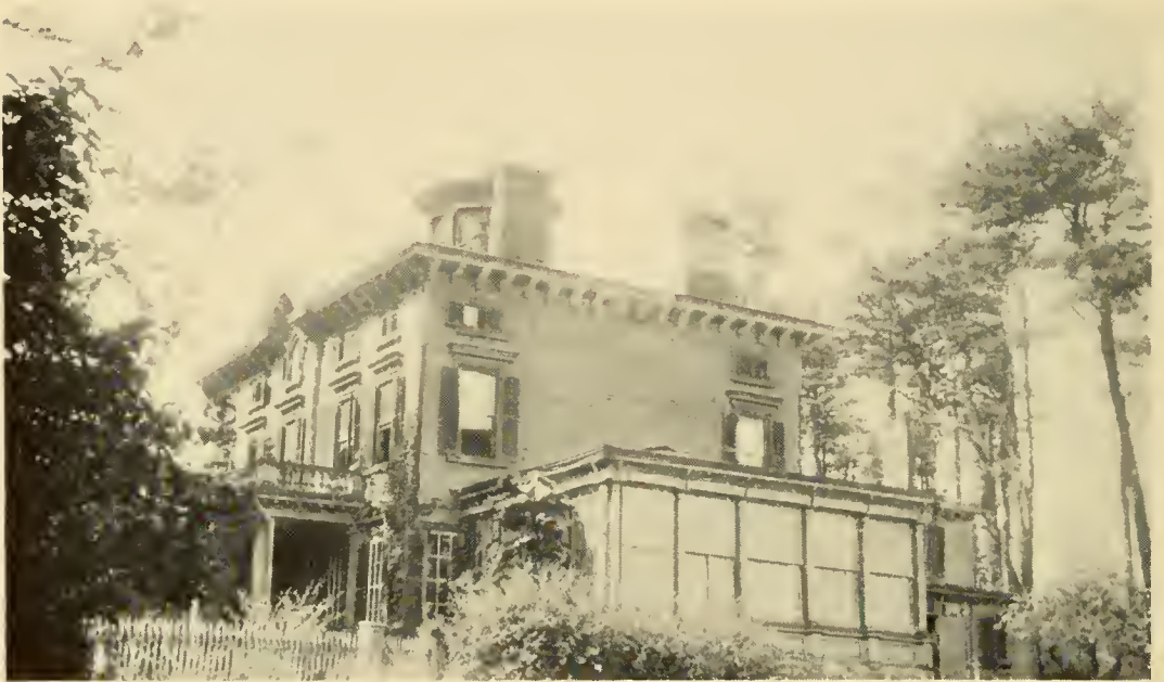
FIG. 61.—Canfield house at Dover, N. J.
