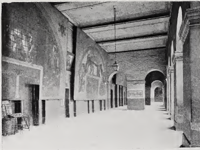
PORTIQUES DE LA COUR ROYALE AUX INVALIDES.
