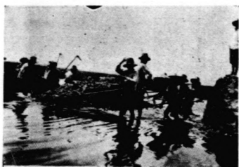
民工拆圍情形
