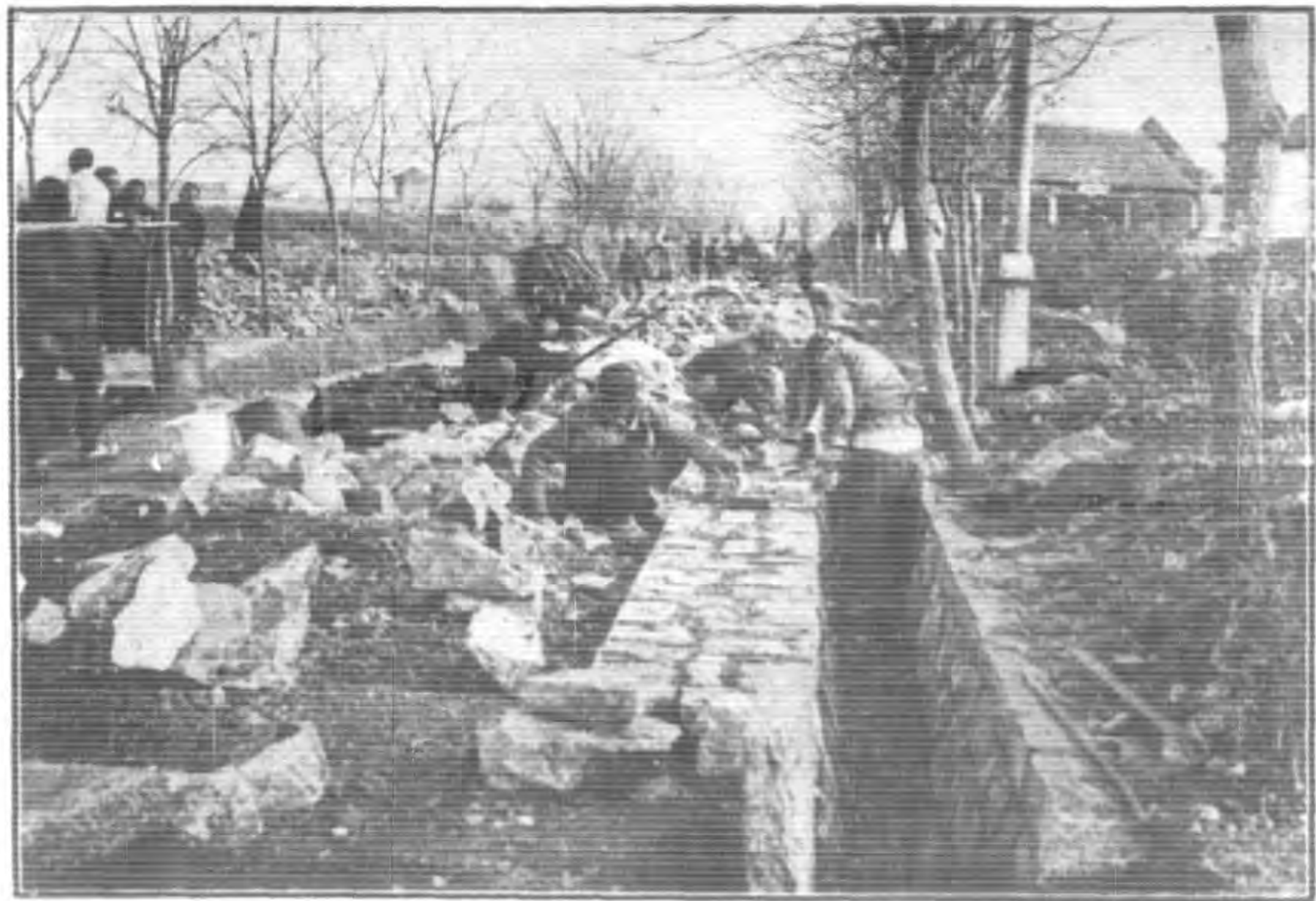
岱安門至地方行政人員訓練所石路先砌明溝工程
