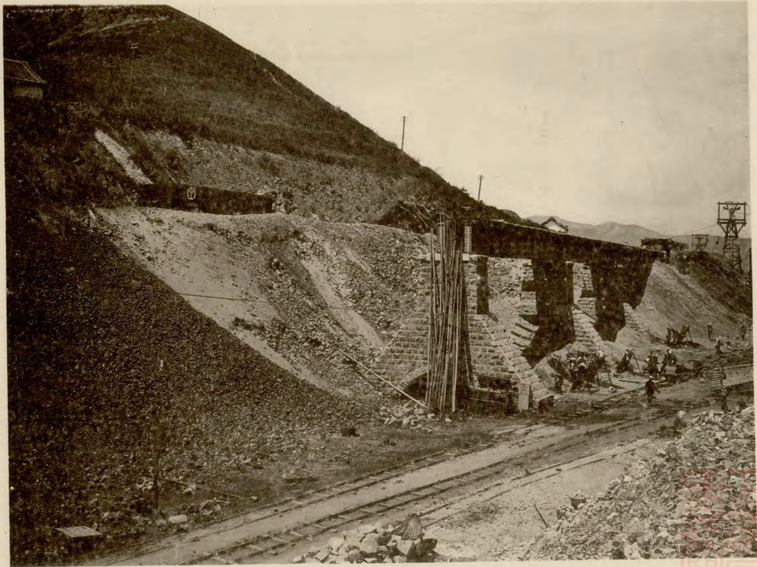
(一十二) 鐵 鑛 石 置 場
