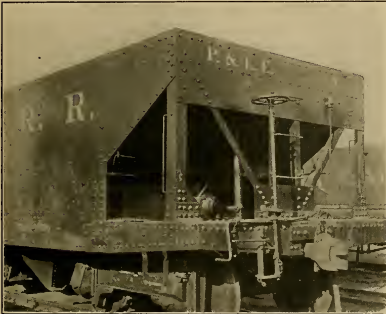
40-TON STEEL HOPPER CAR—P. & L. E. R. R.
