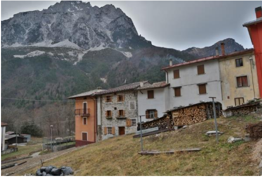
Sehr eng aneinandergebaut und heute fast alle leerstehend, Häuser in Dordolla. 7
