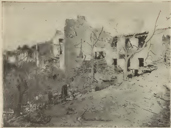
VISTA DE ALGUNOS EDIFICIOS DESTRUIDOS
