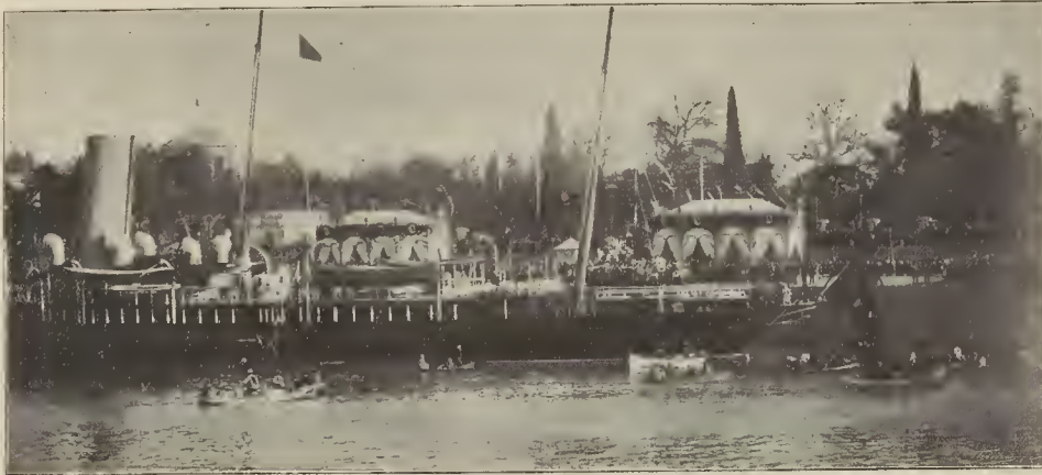
SEVILLA. - MOMENTO DEL DESEMBARCO DE LOS RESTOS DE COLÓN CONDUCIDOS POR EL YATE «GIRALDA» (de fotografía de M. Medina)
