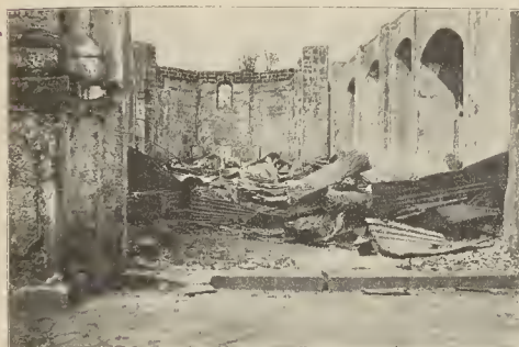
MANILA. — Interior de la iglesia del barrio de Paco, después del incendio
