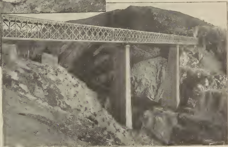
EL VIADUCTO DEL SALADO. — VISTA DEL PUENTE TENDIDO (de fotografía de López, de Baeza)
