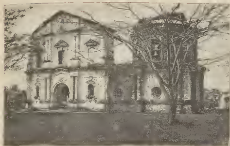
MANILA. — Fachada principal y torre de la iglesia del barrio de Paco, destruida por la artillería yanqui
