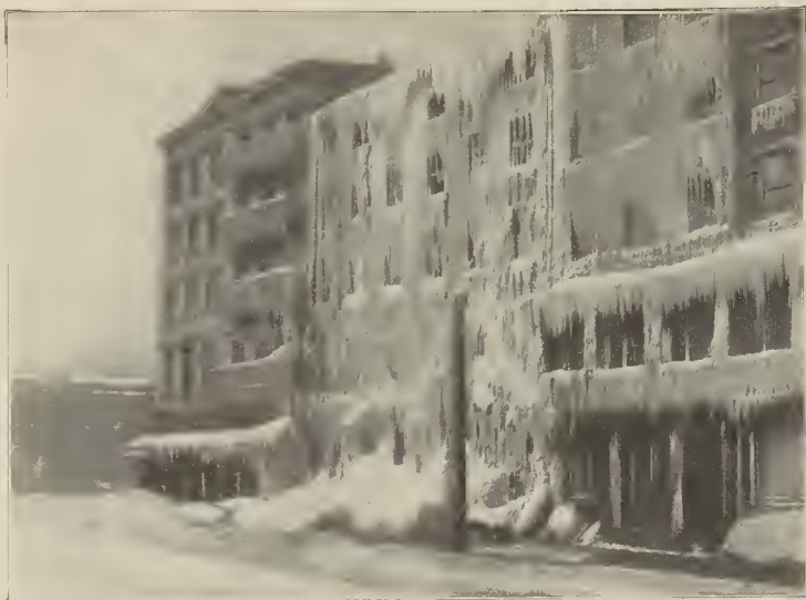
LA TEMPESTAD DE NIEVE EN NUEVA YORK El hotel Whitehall después del incendio, tal como quedó helada el agua que las bombas arrojaron para extinguir el fuego (de fotografía de James Bruton, de Nueva York)
