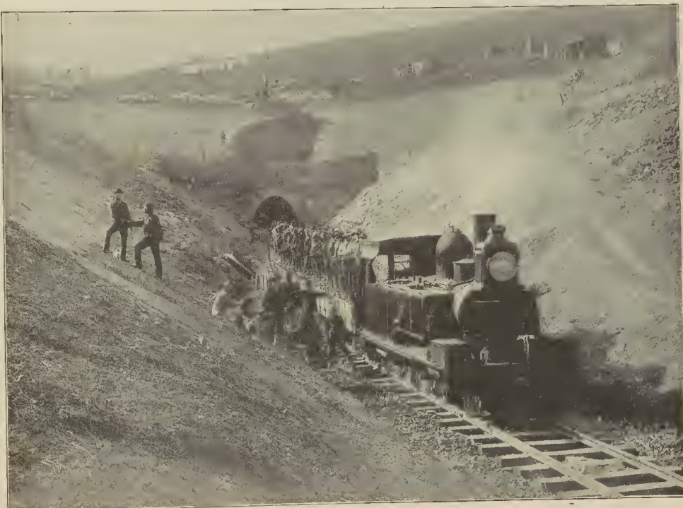
CONFLICTO ENTRE INGLATERRA Y EL TRANSVAAL. - El túnel de Charlestown y la garganta de Laing por donde los boers pueden invadir el territorio de Natal
