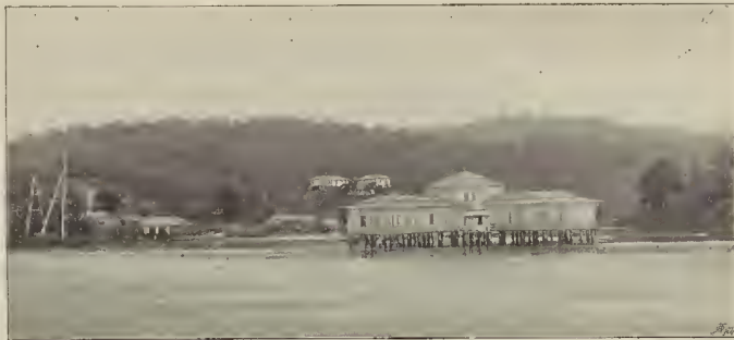
ISLAS FILIPINAS. - ISABELA DE BASILÁN. - ENFERMERÍA NAVAL ESPAÑOLA CONSTRUÍDA SOBRE PILOTAJES (de fotografía de M. Arias y Rodríguez)
