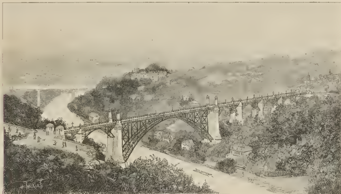
Fig. 1. - Vista general del puente de Kornhaus en Berna
