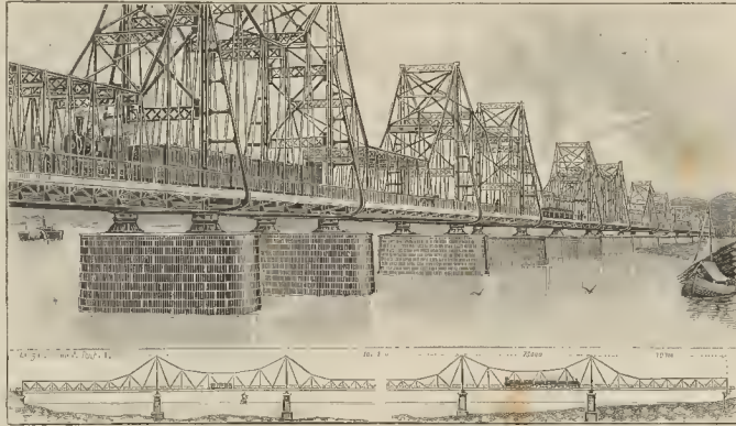
Puente de 1.680 metros que se construye sobre el río Rojo, en el Tonquín
