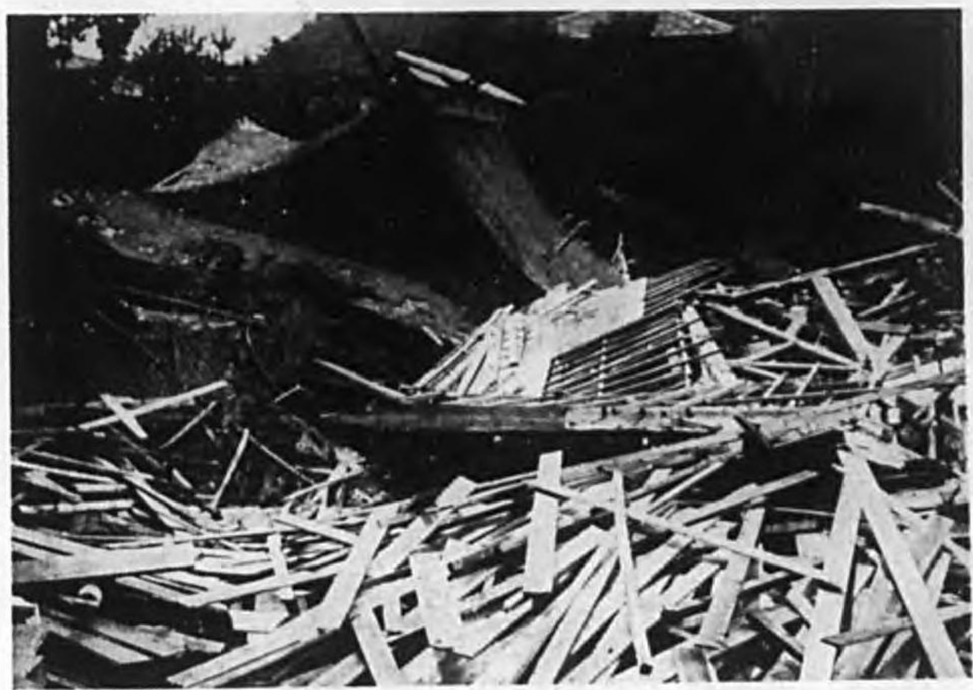
破却直後の彌勒殿の一部及至聖殿を示す
