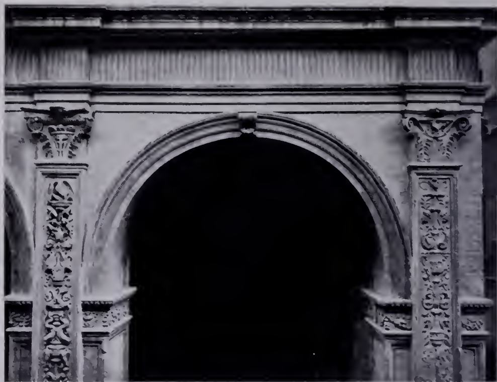
Fig. 393 — Bologna, Chiesa di S. Bartolomeo. Andrea da Formigini: Particolare d'un'arcata del portico. (Fot. Poppi).
