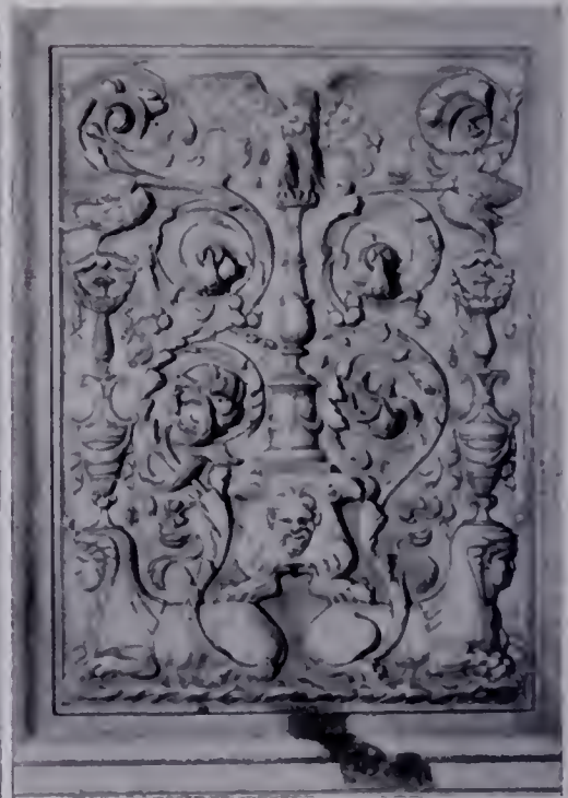
Fig. 214 — Loreto, Basilica della Santa Casa. Gian Cristoforo Romano (imitatore di): formella nel basamento della Santa Casa. (Fot. Ceccato).
