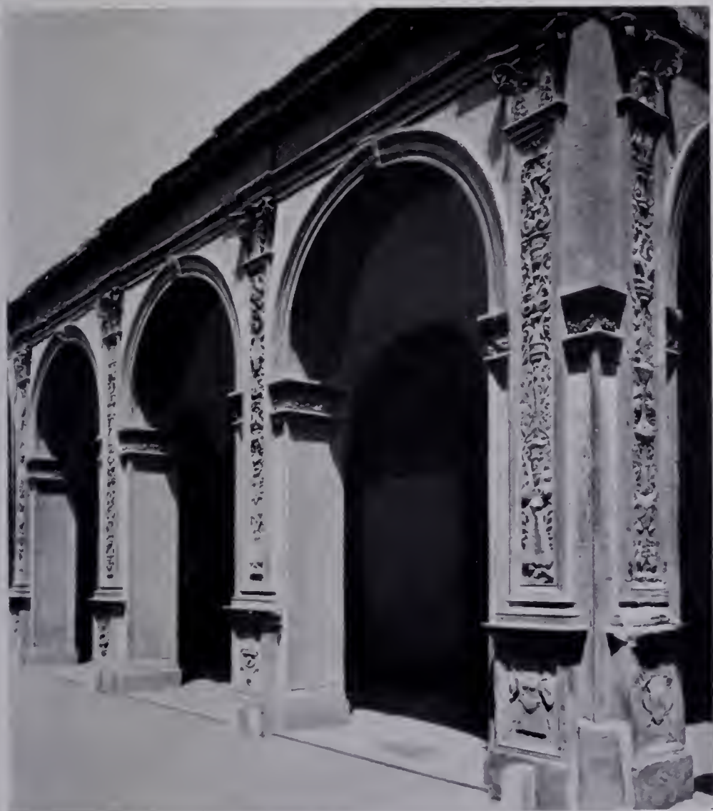
Fig. 392 — Bologna, Chiesa di S. Bartolomeo. Andrea da Formigini: Portico. (Fot. Poppi)
