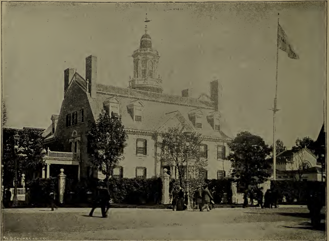
Das Massachusetts-Gebäude war eine Nachbildung des berühmten Wohnhauses von John Hancock, welches für längere Zeit ein Merkzeichen in Boston war. In der Front befand sich ein Garten, welcher mit alterthümlichen Blumen und Gesträuchern bepflanzt war. Das ziemlich große Gebäude enthielt Säle, Empfangszimmer und Amtsstuben und hatte $50,000 gekostet.
