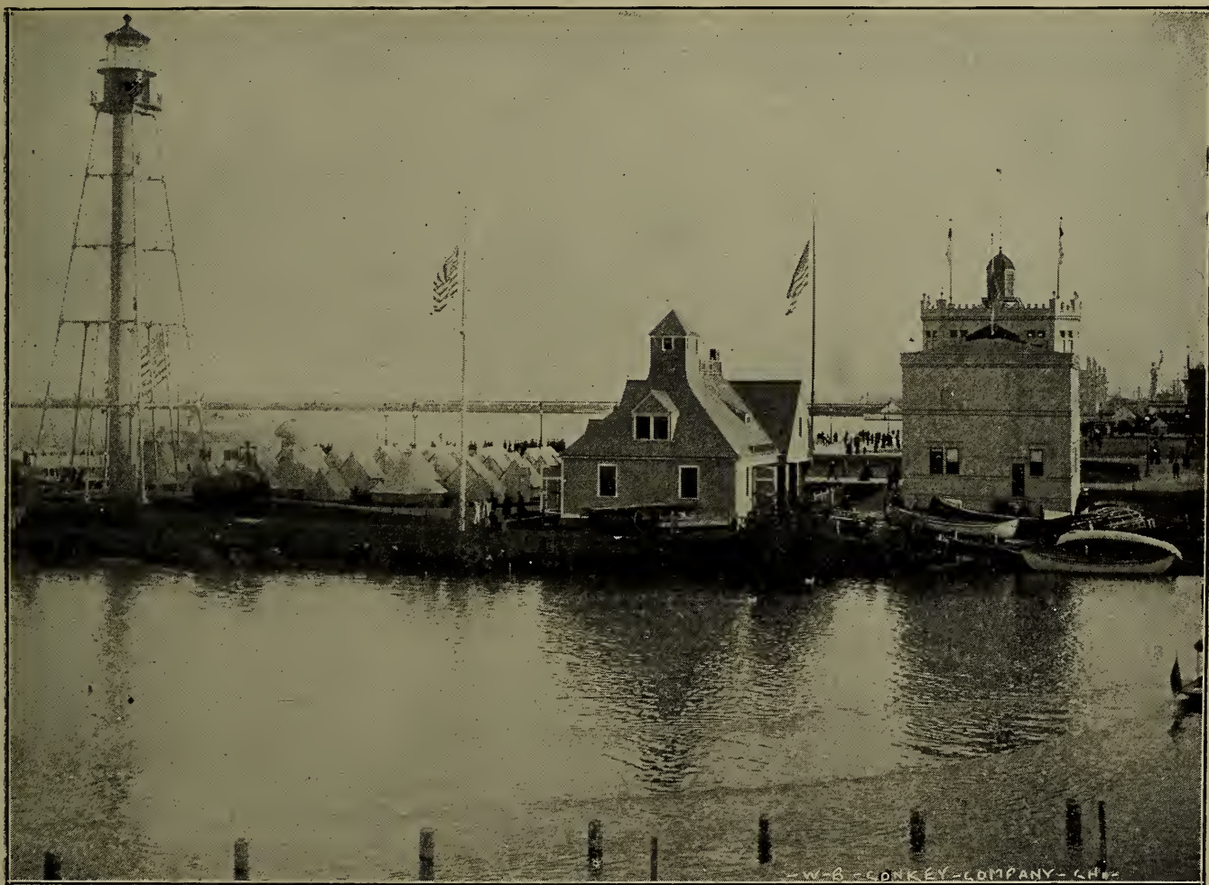
Das Marine-Observatorium, die Lebensrettungs-Station, Leuchtturm-Ausstellung und das Wetter-Bureau waren nahe zusammen an dem Seeufer, direkt südlich von der nördlichen Einfahrt, gruppiert. In der Abbildung erscheinen die jenen Zwecken bestimmten Gebäude im Vordergrund. Im Hintergrund links ist das Ver. Staaten Militär-Lager. In weiterer Entfernung ist die Statue der Republik zu erblicken.
