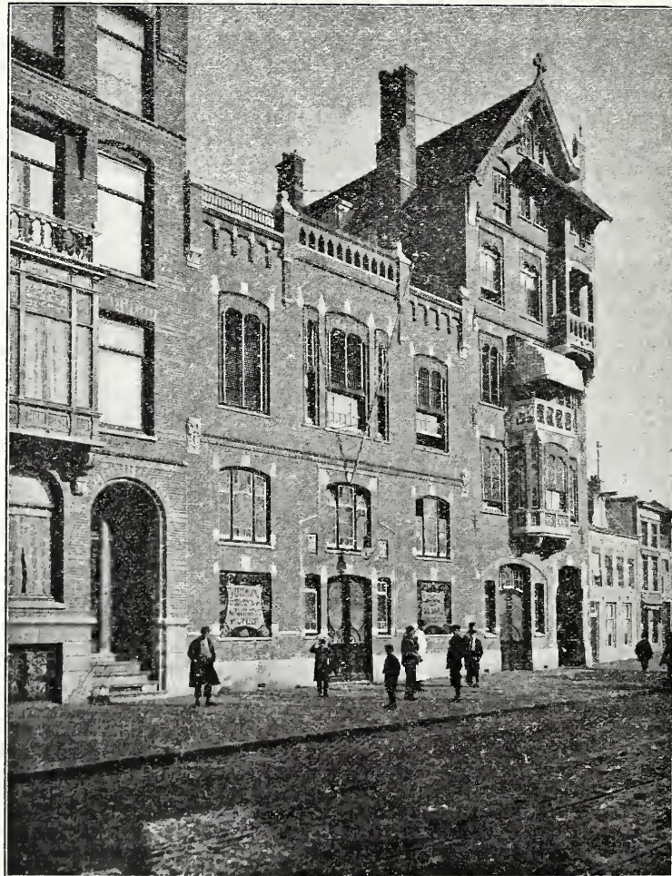
School voor Vocaal- en Dramatisch Kunstonderwijs te Amsterdam. Architecten D. J. Nijland en C. L. van Kesteren.
