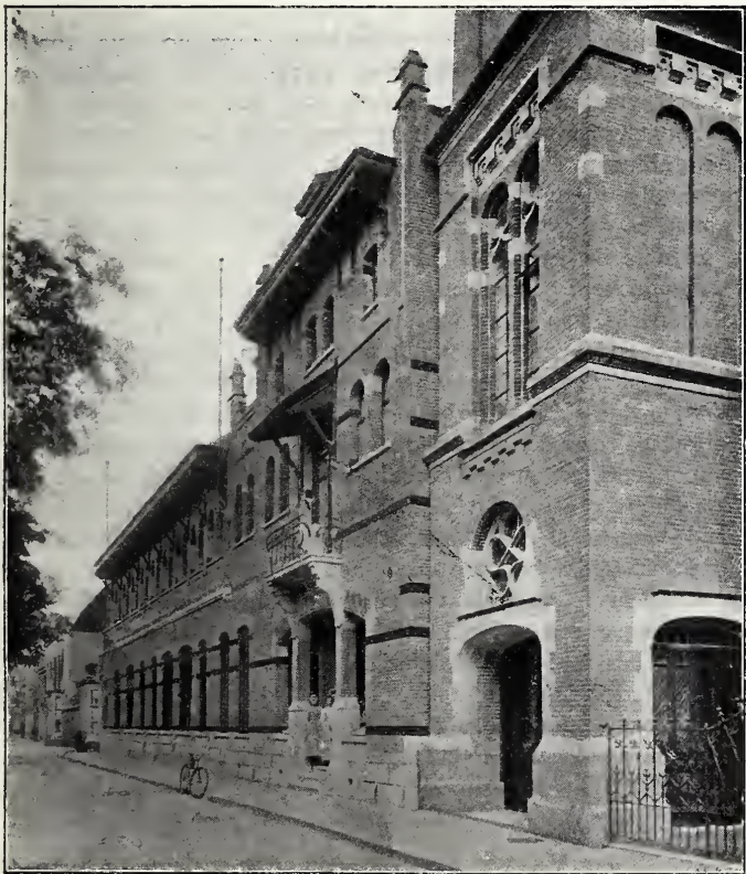
Voorgevel van het Waalsche Weeshuis te 's-Gravenhage. Architect J. P. Srok Wz.
