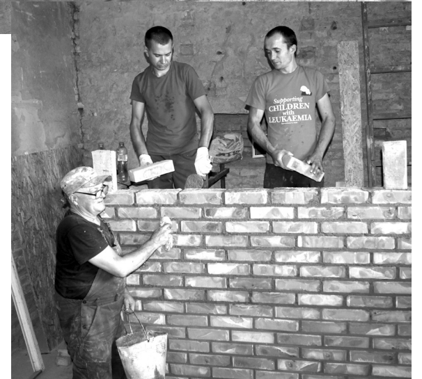
Будівельні роботи в новому цеху: скоро тут буде побутова кімната з усіма зручностями. Працюють Ілля Колода, Петро Журавльов і Олександр Романюха
