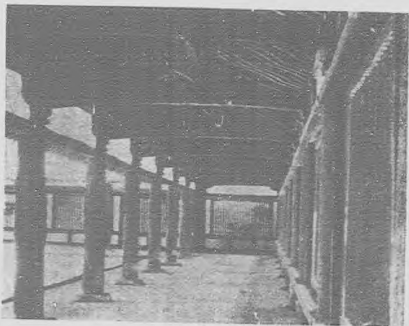
甲 日本奈良法隆寺廻廊
