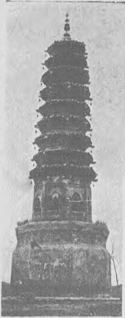
乙 遼寧鐵嶺龍首山磚塔
