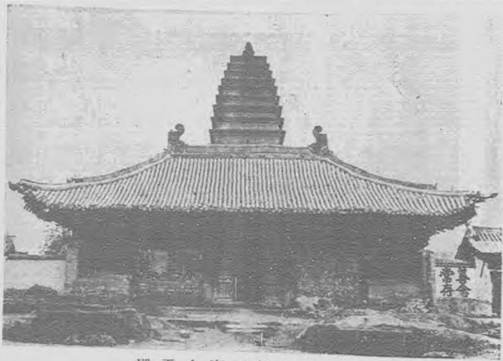
乙 沁陽縣天寧寺正殿
