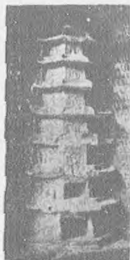
己 浙江杭州煙霞洞石塔
