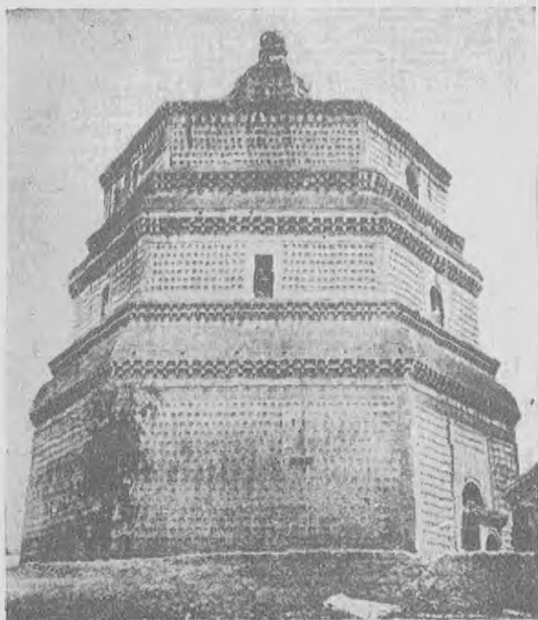
戊 河南開封相國寺繁塔
