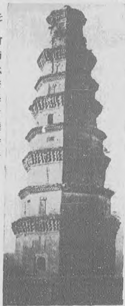
庚 河南武安縣常樂寺塔
