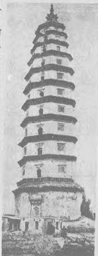
丁 河北定縣開元寺料敵塔東南面
