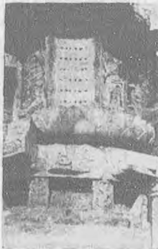
己 棲霞寺舍利塔詳部
