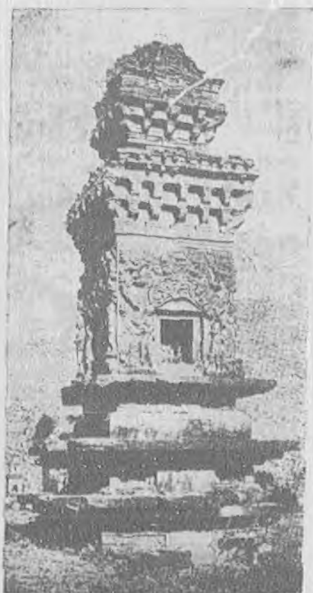
丙 山東歷城縣神通寺朗公塔
