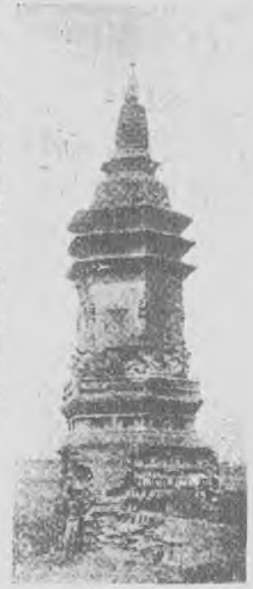
甲 河北順德天寧寺塔
