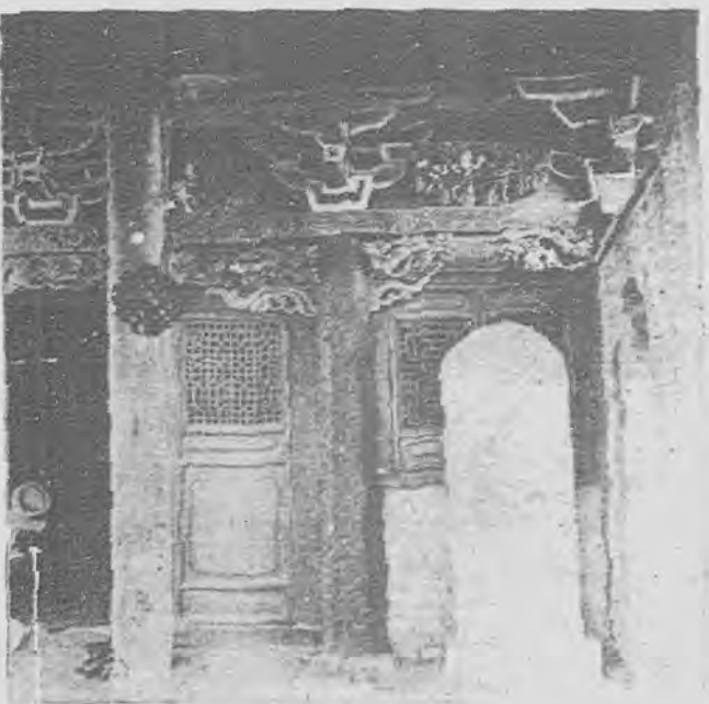
丙 二郎廟正殿詳部
