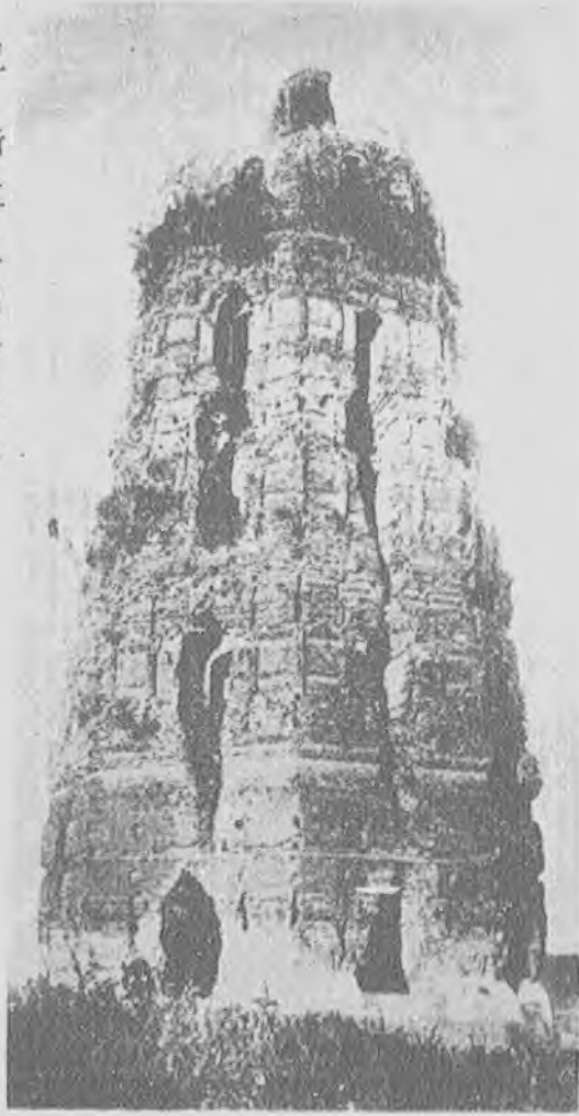
己 浙江杭州雷峯塔
