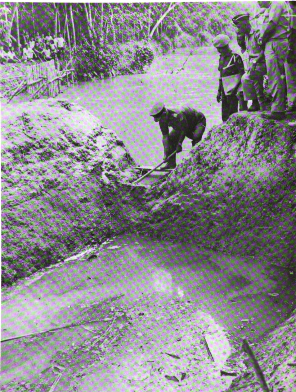
Gubsu Brigdjen. MARAH HALIM sewaktu melakukan pentjangkalan pemasukan air pertama dari bendungan ke tali air persawahan Sei Ledong Ketj. Indrapura Kab. Asahan pada bulan Mei 1968. -
