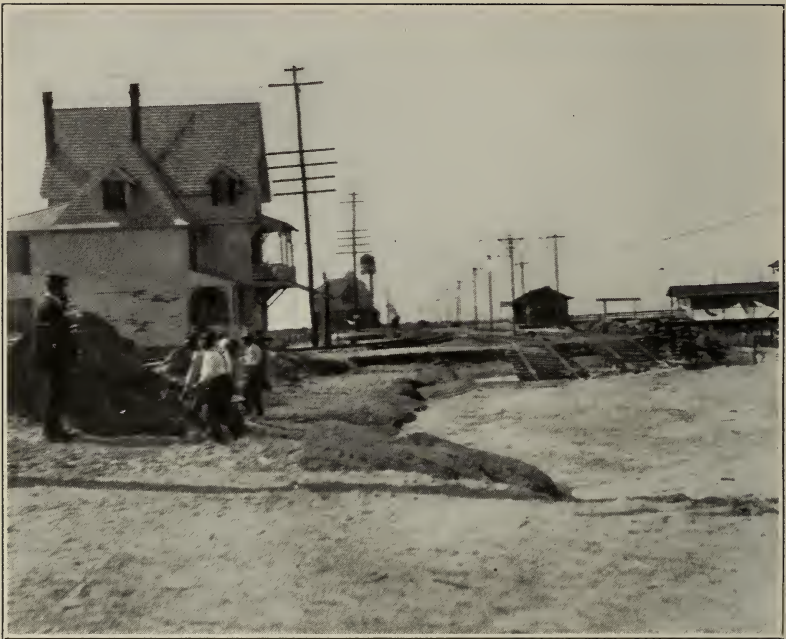
Fig. 1. Sink hole at Longport, N. J.
