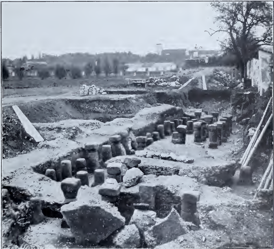
Abb. 108. Hypokaustenpfeiler eines großen heizbaren Gebäudes im Lager von Lauriacum. Vgl. Der römische Limes in Österreich XI (1910), S. 25 f.
