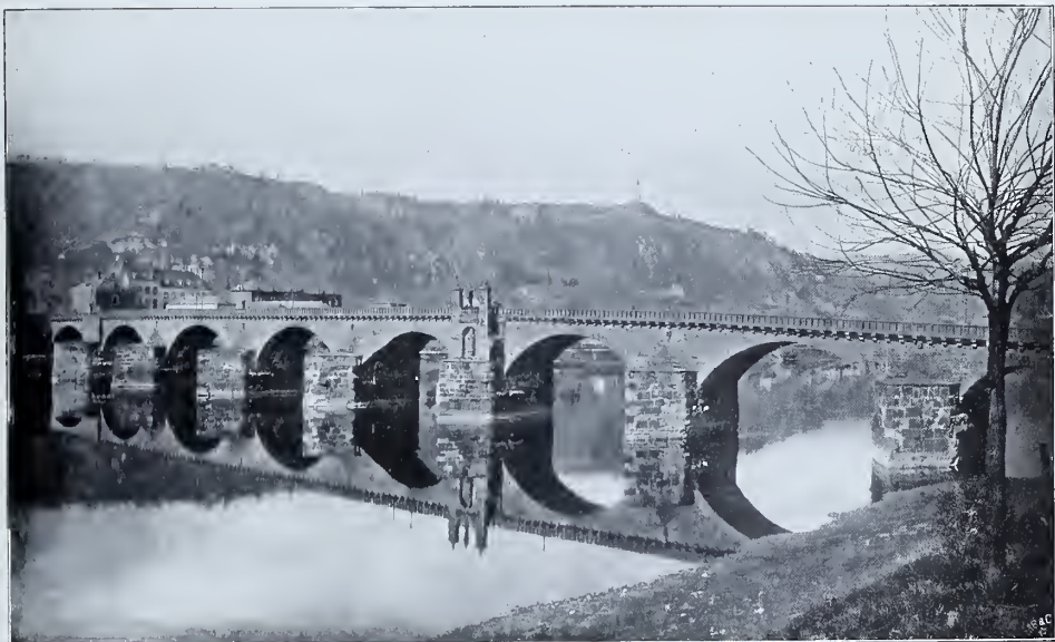
☞ Abb. 57. Die Moselbrücke bei Trier. Die Pfeiler sind römisch. (Zu Seite 126.) ☞
