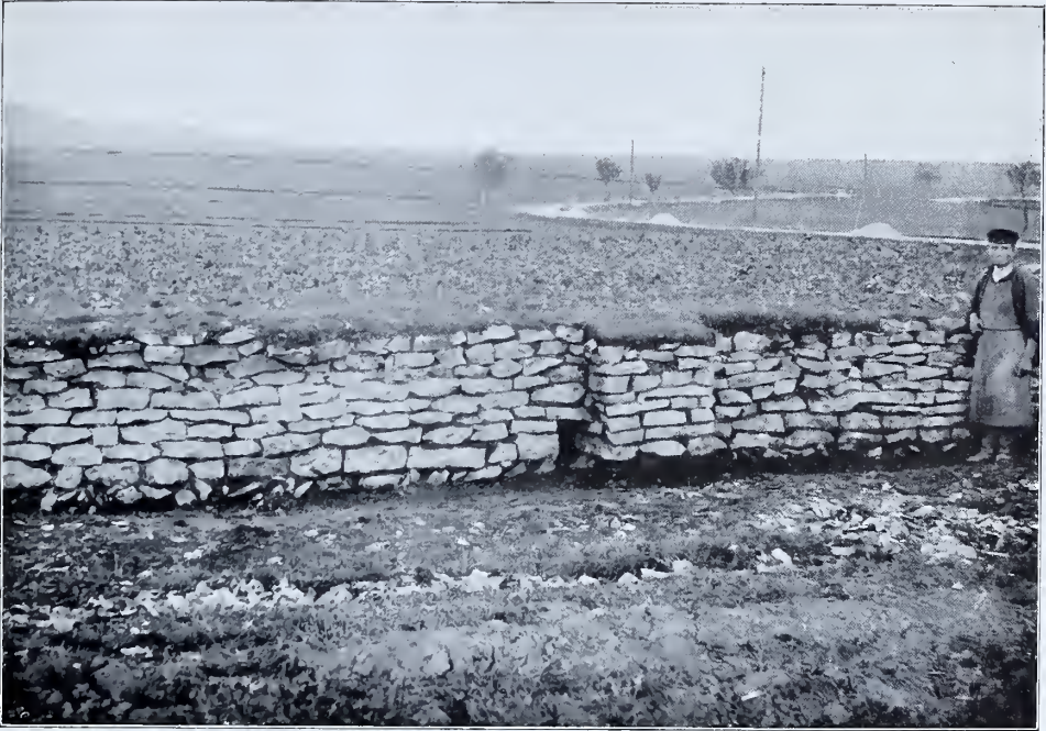
☒ Abb. 39. Die Mauer des rätischen Limes bei Ellingen-Kalldorf. (Zu Seite 71.) ☒
