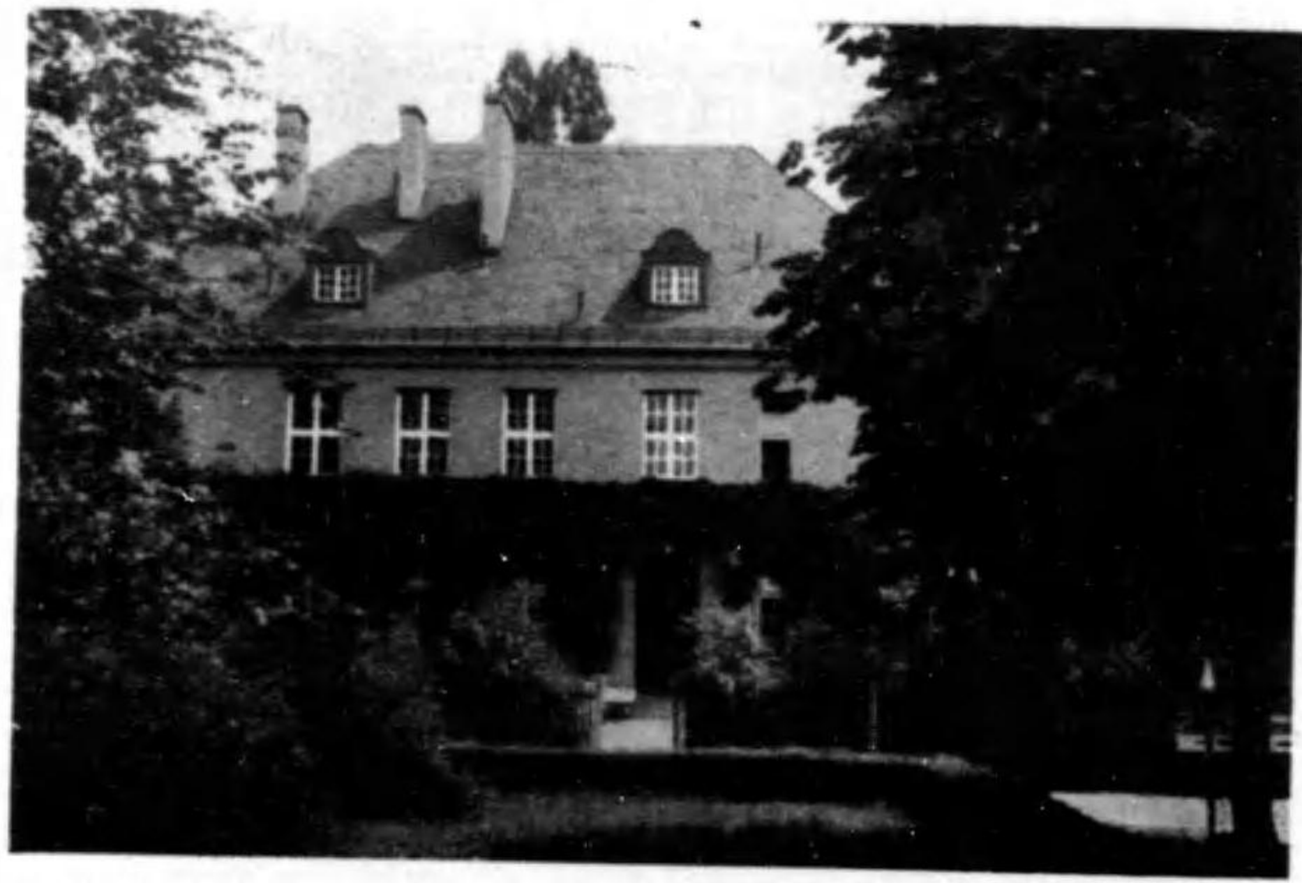
ドイツ精神病学研究所臨牀心理学研究室, 隔離病舎 (ミュンヘン・シュワービング病院第五號別棟) の入口.
