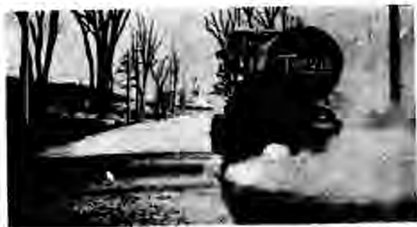
圖 69 用自動車噴灑封面層，每方碼用 \frac{1}{2} 加侖
