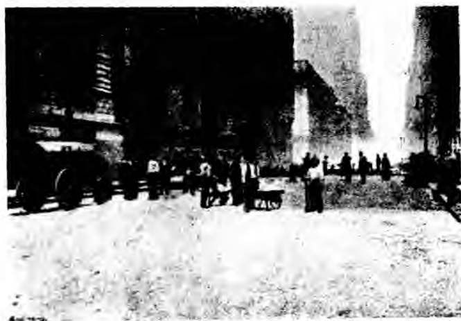
圖 95 木塊路面上之鋪砂以作填塞料
