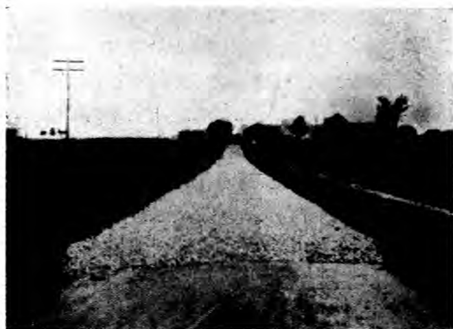
圖 62 馬卡達姆路下層路面之鋪築法
