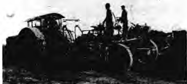
圖 54 升起築路機，裝土入傾卸車之狀
