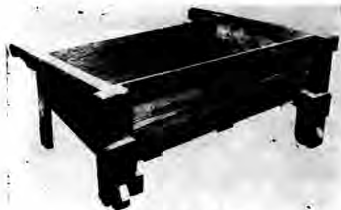
圖 86 鋪設磚路面所用之灰漿箱
