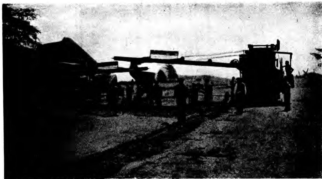
鋼筋混凝土路面,使用混凝土混合機
