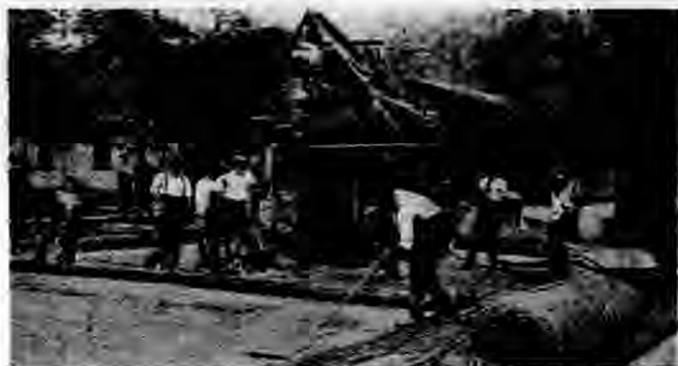
圖 70 鋪築鋼筋混凝土路，織紋鋼料置於前邊，即預備放於上下兩層之間
