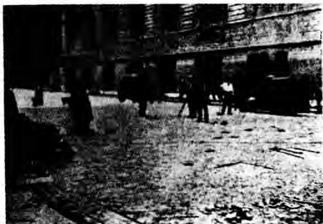
圖 94 木塊路面之夯擊及深壓以備灌入填塞料
