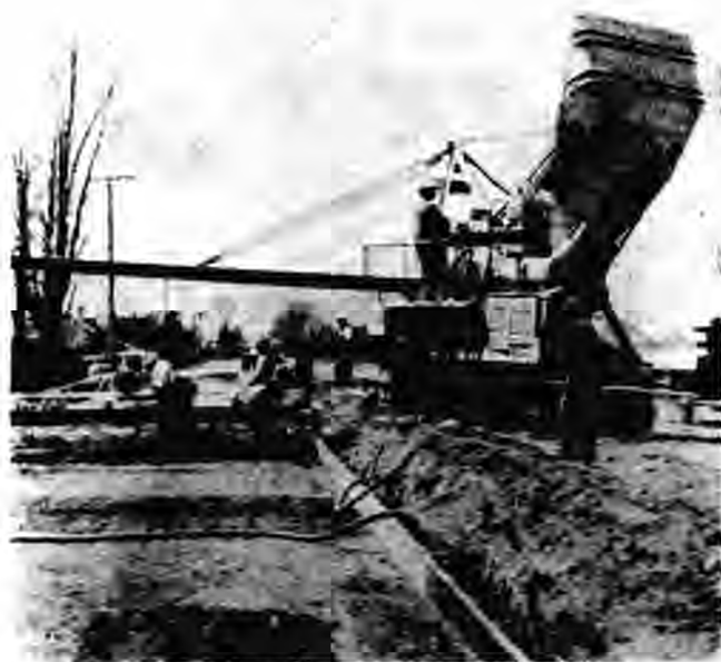
圖 90 路工所用之 歐式佛特 泥灰土混合機及運送機
