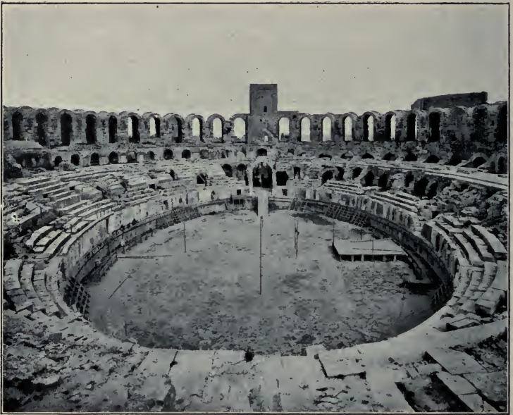
21. Amphitheater, Innenansicht (Arles).
