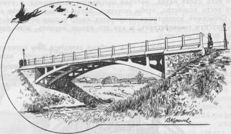
Жельзо-бетонный мостъ въ 12 саж. черезъ р. Томаковку, Екат. уѣзда.
