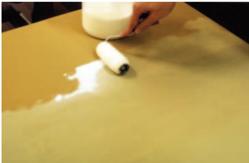
Figura 19 – Aplicação de adesivo sobre o tecido de microfibras de poliéster.
