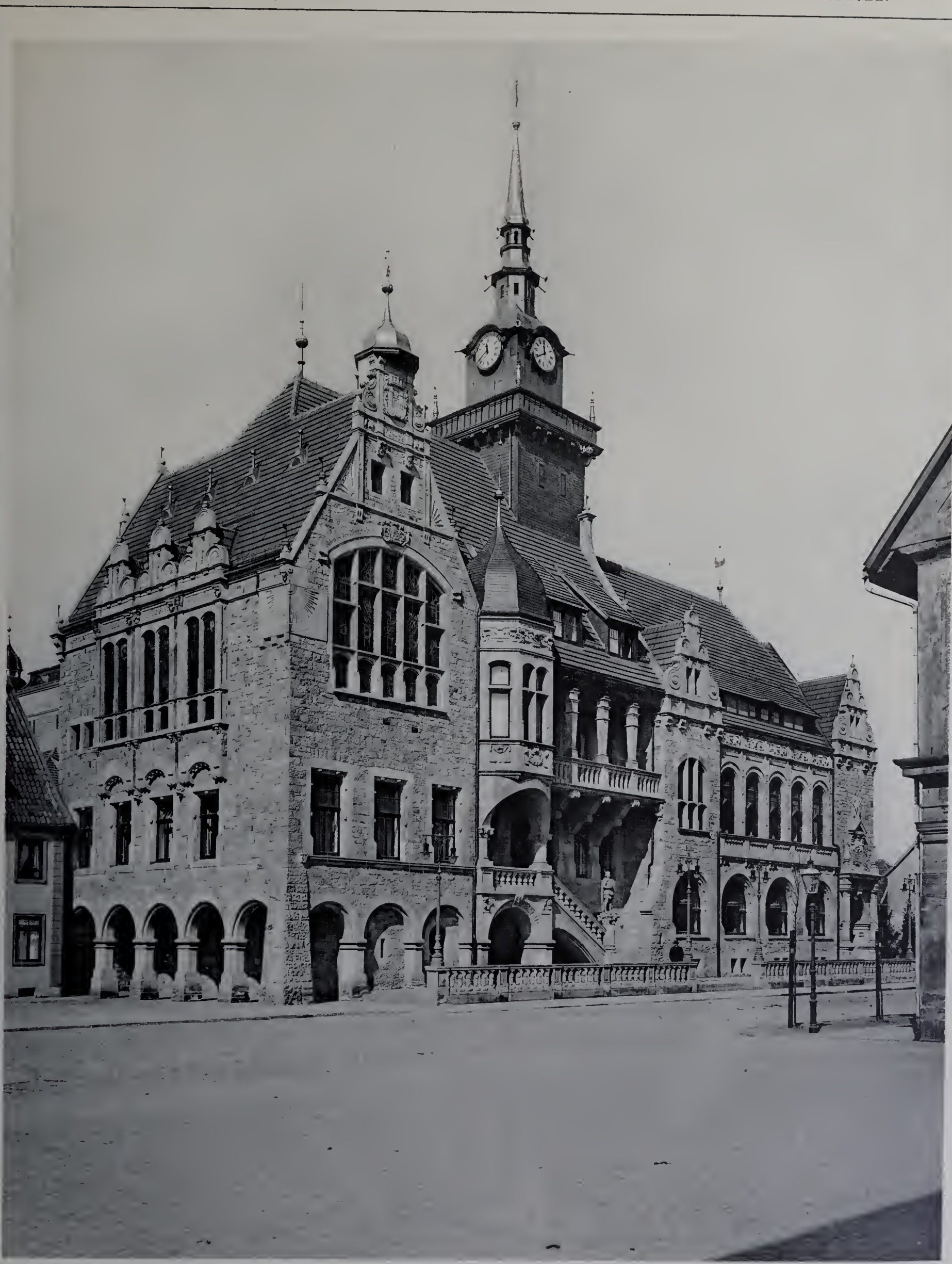
Architekt: Alfred Sasse, Hannover.
