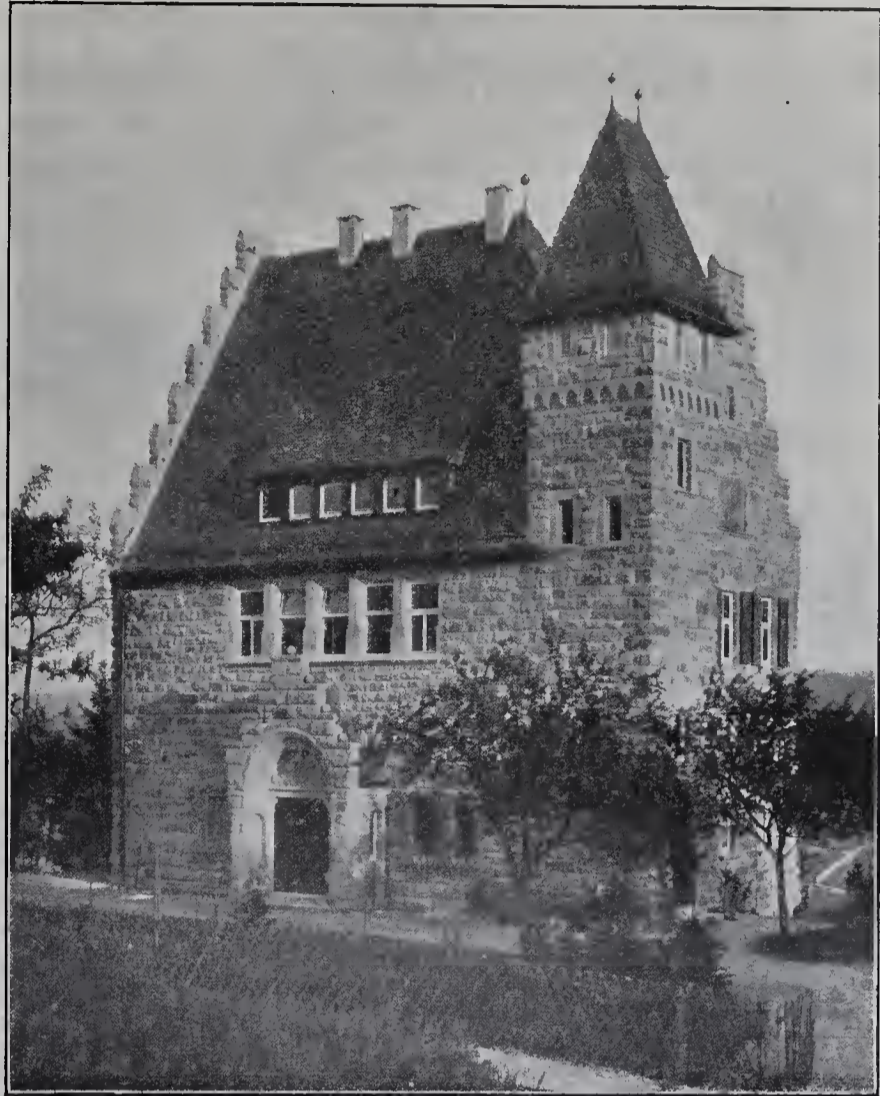
Das Haus der Landsmannschaft Schottland in Tübingen. Architekt: Arthur Müller in Stuttgart. (Siehe Tafel 1 vom Hauptblatt.)
