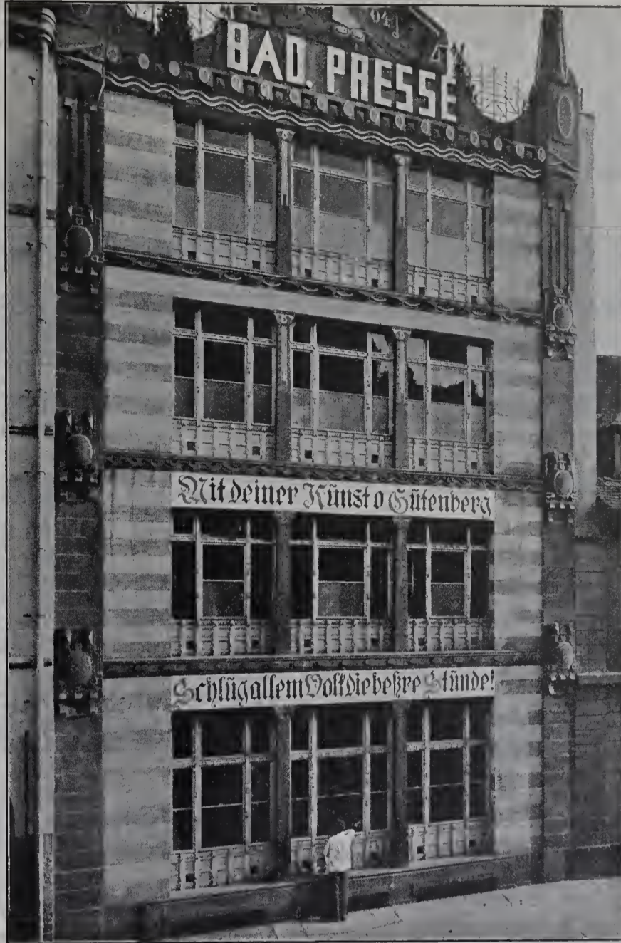
Das Druckereigebäude der „Badischen Presse“ in Karlsruhe.
