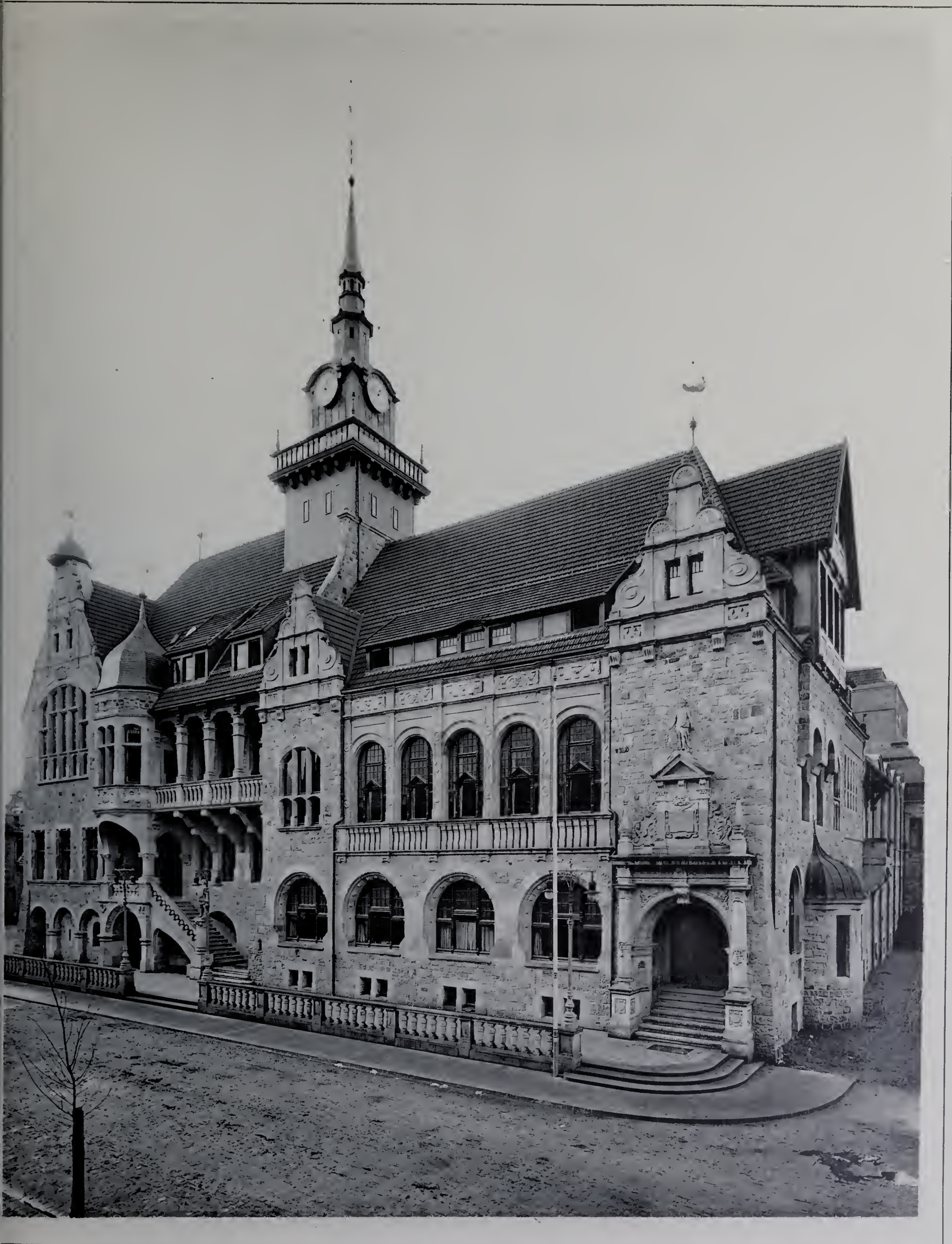
Architekt: Alfred Sasse, Hannover.
