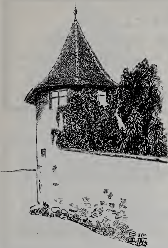
1. „Pulverturm“ am Bodensee.
