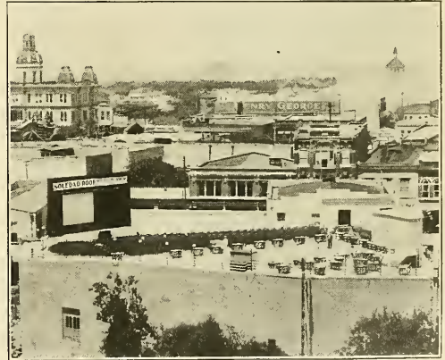
The roof of the Soledad.
