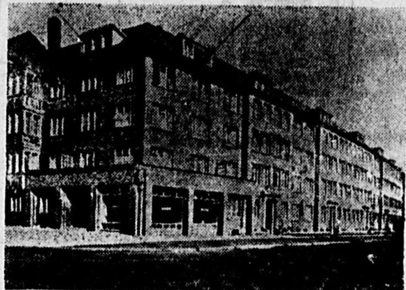
第277圖 同上 (改造後の状態)
