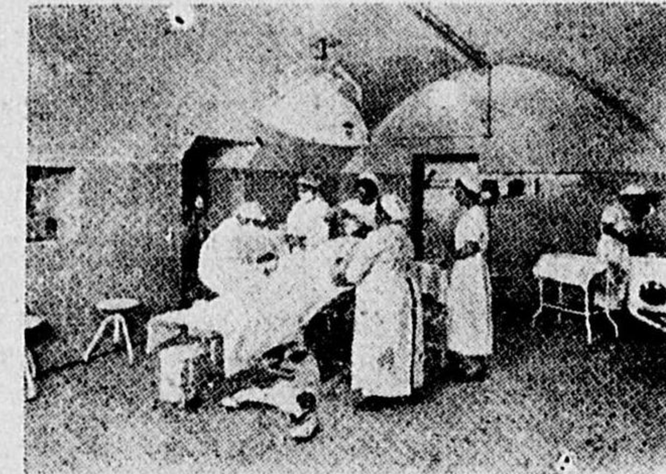
第231圖 耐弾救護所内の手術室 1) (ドイツの某工場)
