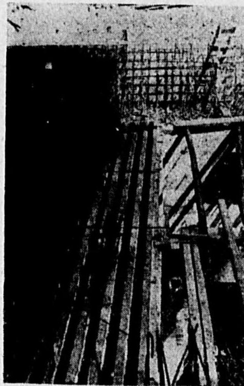
第22)圖 工事中の或る耐弾防護室 (鋼絛コンクリート梁及び屋版補強用鐵筋の配置)
