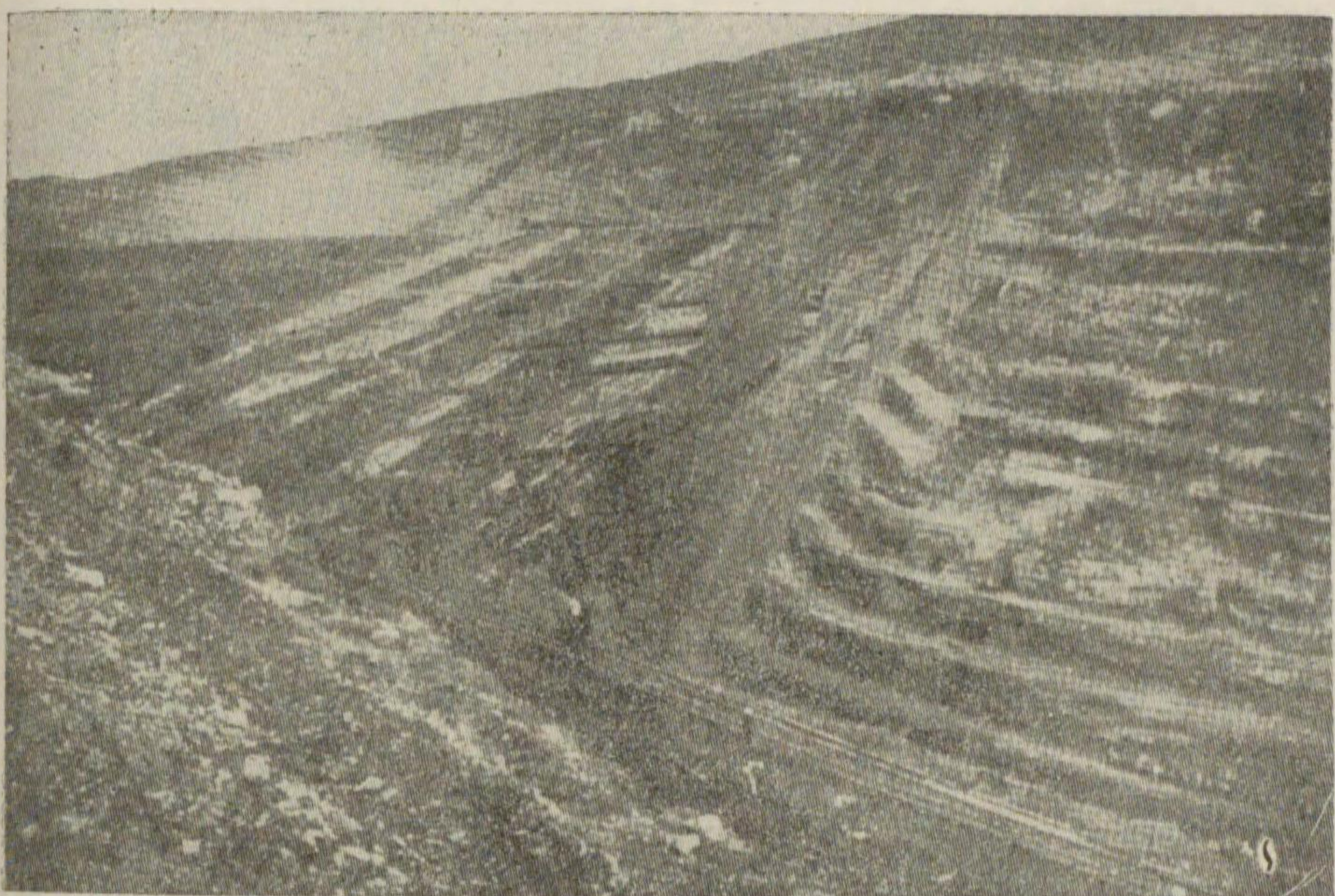
撫順炭坑の露天掘 撫順炭坑の炭石の質は十八フイ ト乃至四百二十フイの層をなしてをる。それをして露天掘で採る。満洲の經濟的價値の大なる。掘り直して貨車で搬送する光景は、満洲の經濟的價値の大なる。掘り直して貨車で搬送する光景は、満洲の經濟的價値の大なる。
