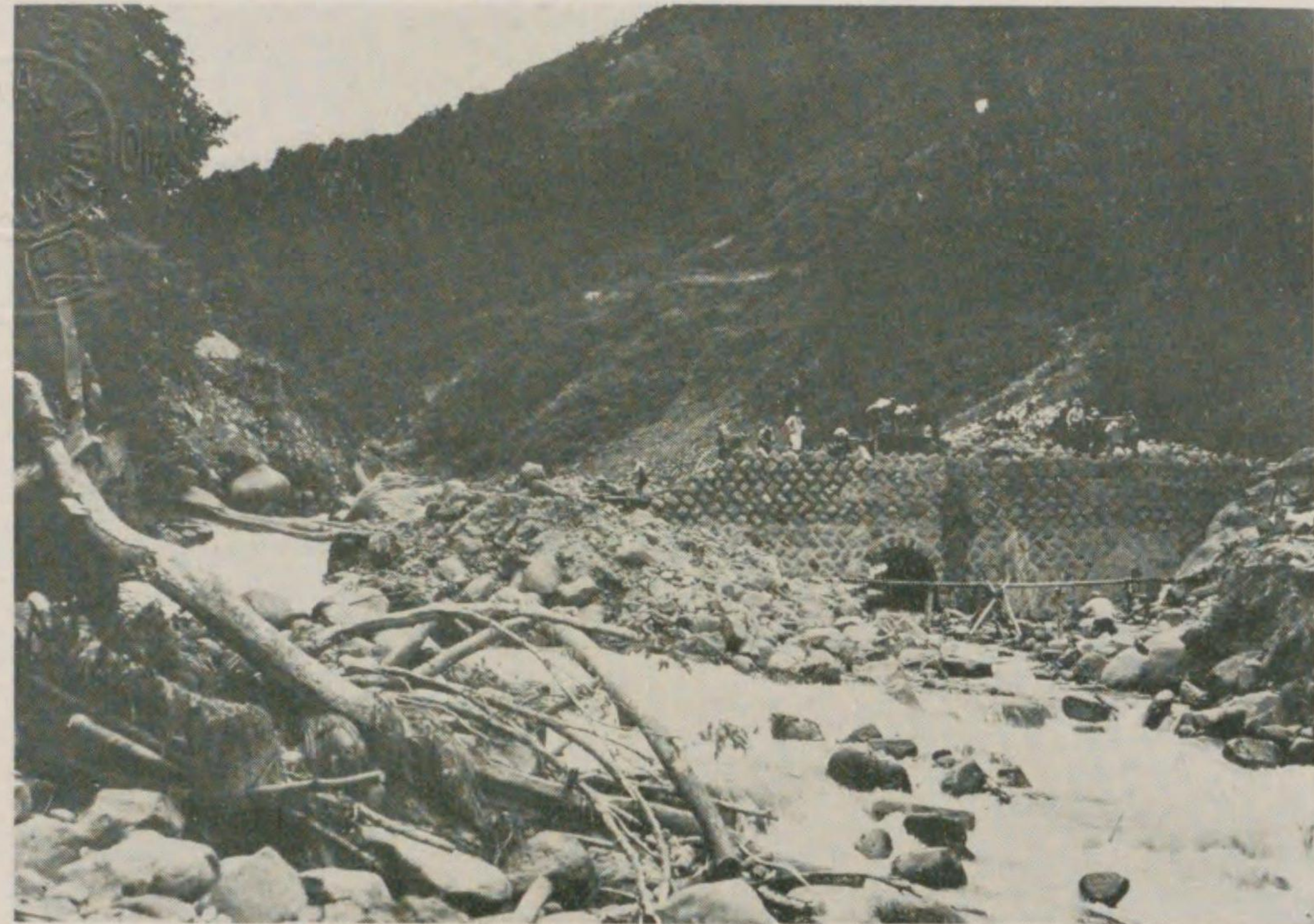
a. 本地方ハ水源地崩壊ノ爲土砂ノ流失多ク、豁谷ヲ埋メ下流ニ及ボス被害大ナラントスルヲ以テ之ニ堰堤ヲ築設スルノ必要ヲ認メ實行中ノ狀況ナリ
