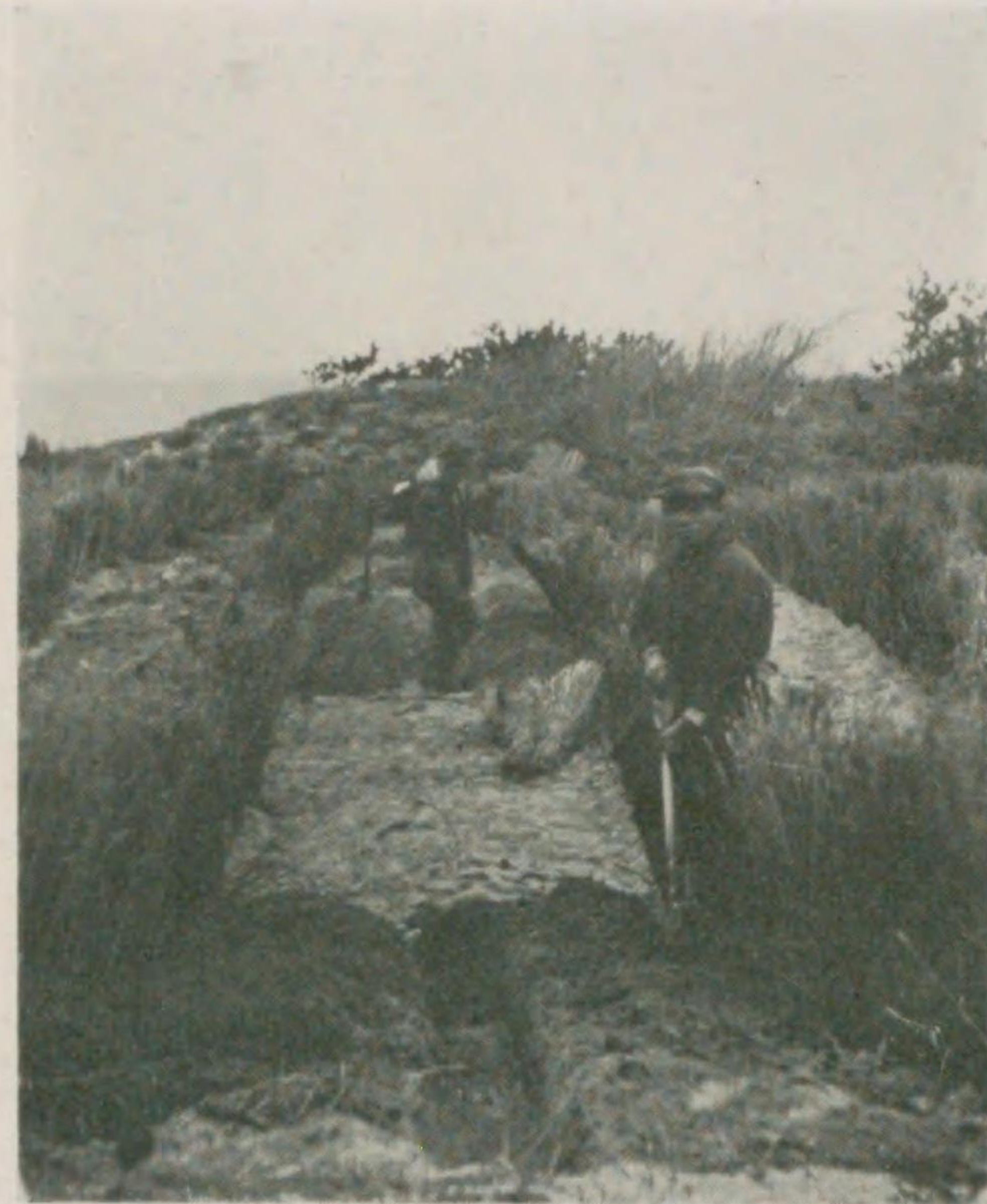
c. 立藁ヲ終リ埋藁施行中ノ状況ニシテ埋藁ハ植栽木ノ水分保持及養料トシテ頗有效ナリ
