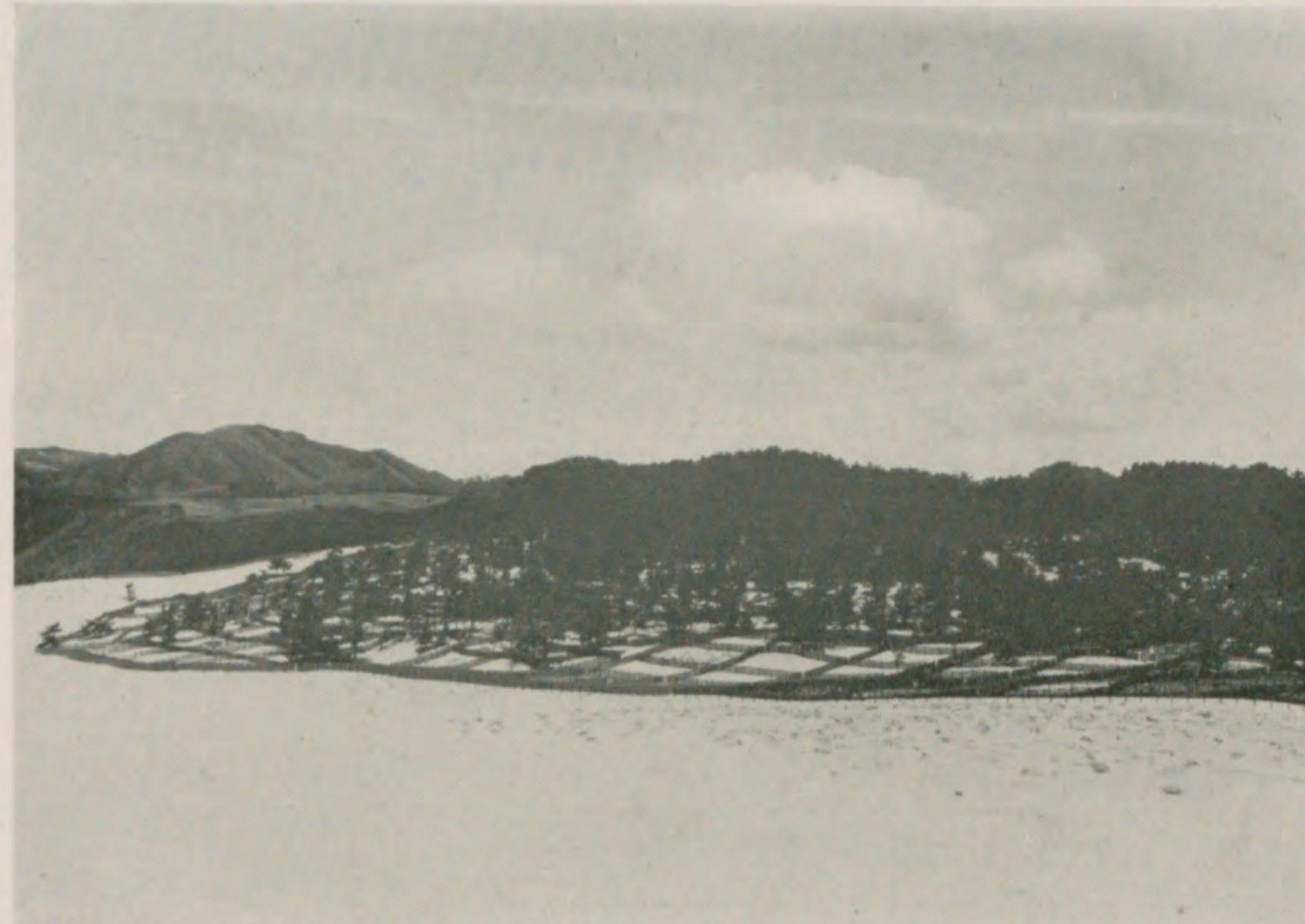
b. 砂防垣ヲ施設シテ先ヅ飛砂ノ安定ヲ圖リ次デ砂防植栽ヲ實行スルノ計畫ナリ、數年ヲ出デズシテ飛砂ヲ防止シ保安ノ目的ヲ達成スルニ至ルベシ
