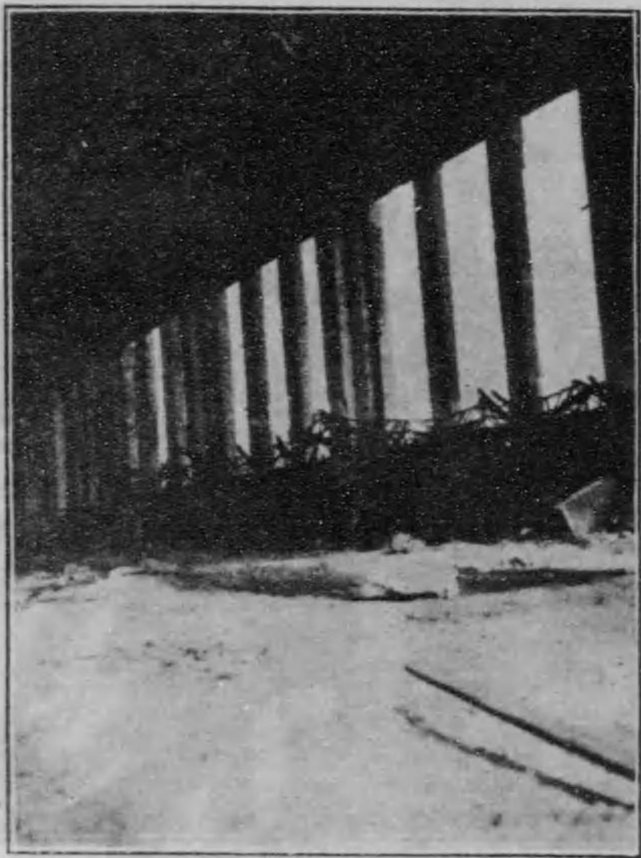
第七圖 東京市日本橋區濱町電話分局 交換室
