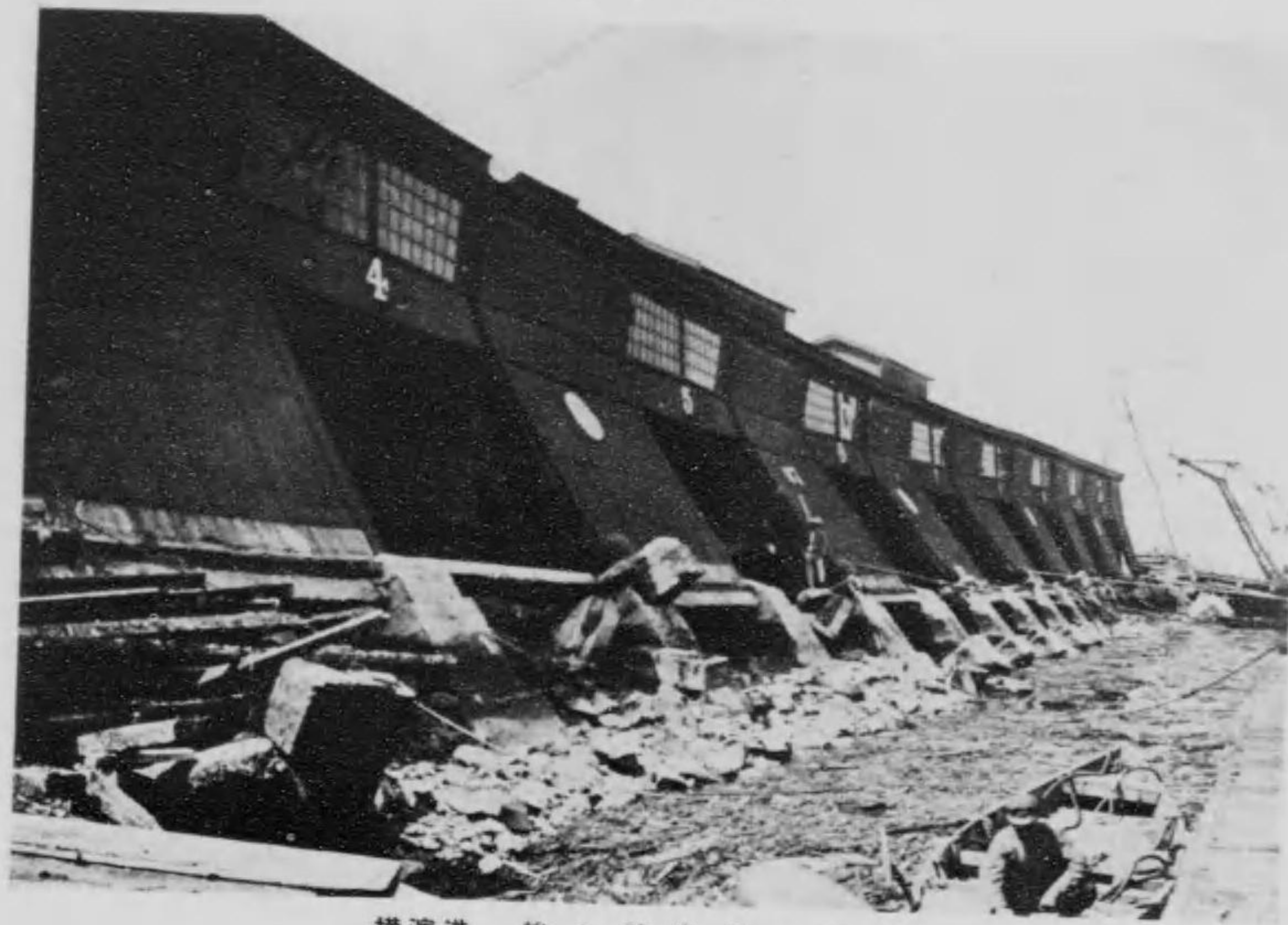
横濱港 第七號岸壁の破壊
