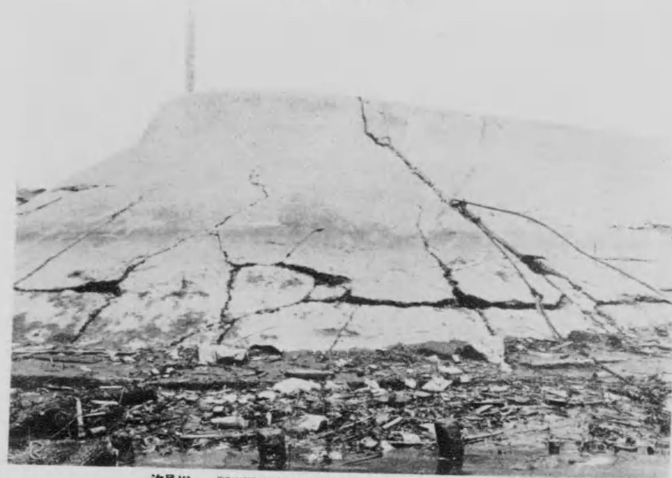
汐見川 深川區汐崎町第一號埋立地平久川合流點混凝土護岸
