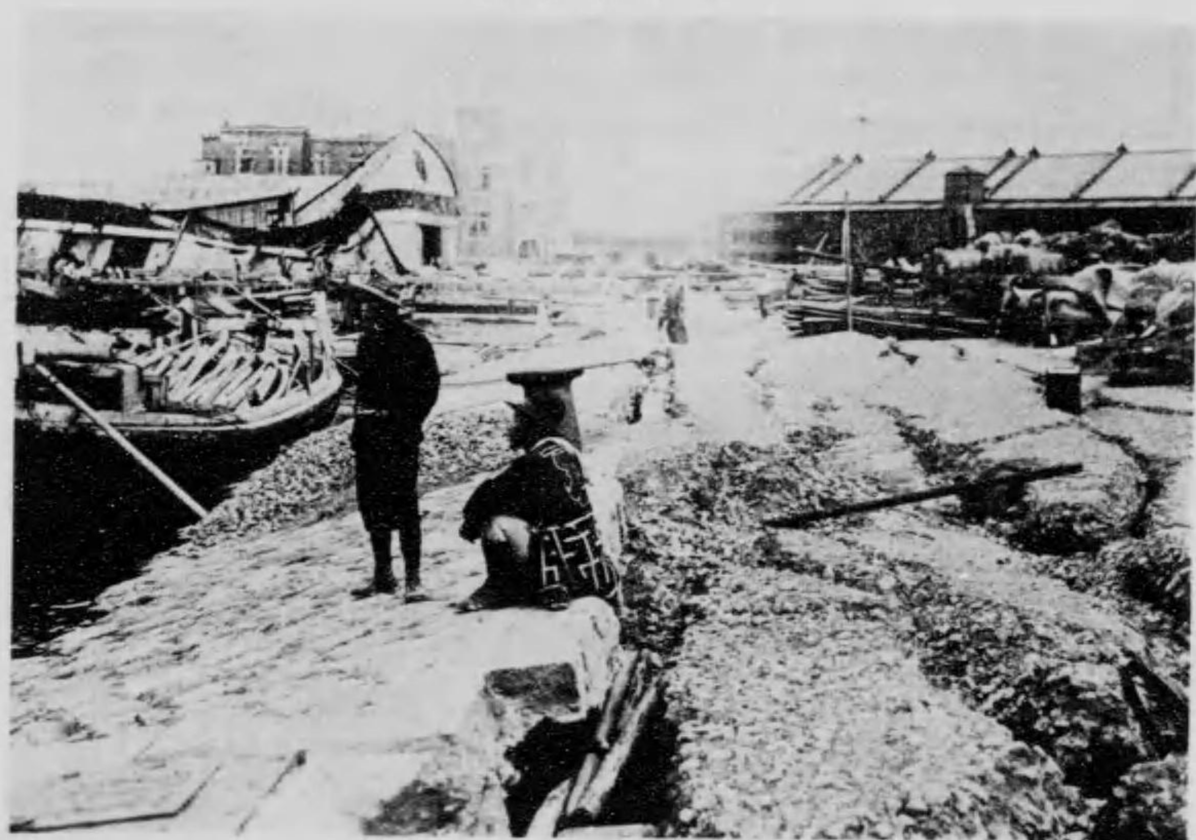
横濱港 第一號物揚場の破壊
