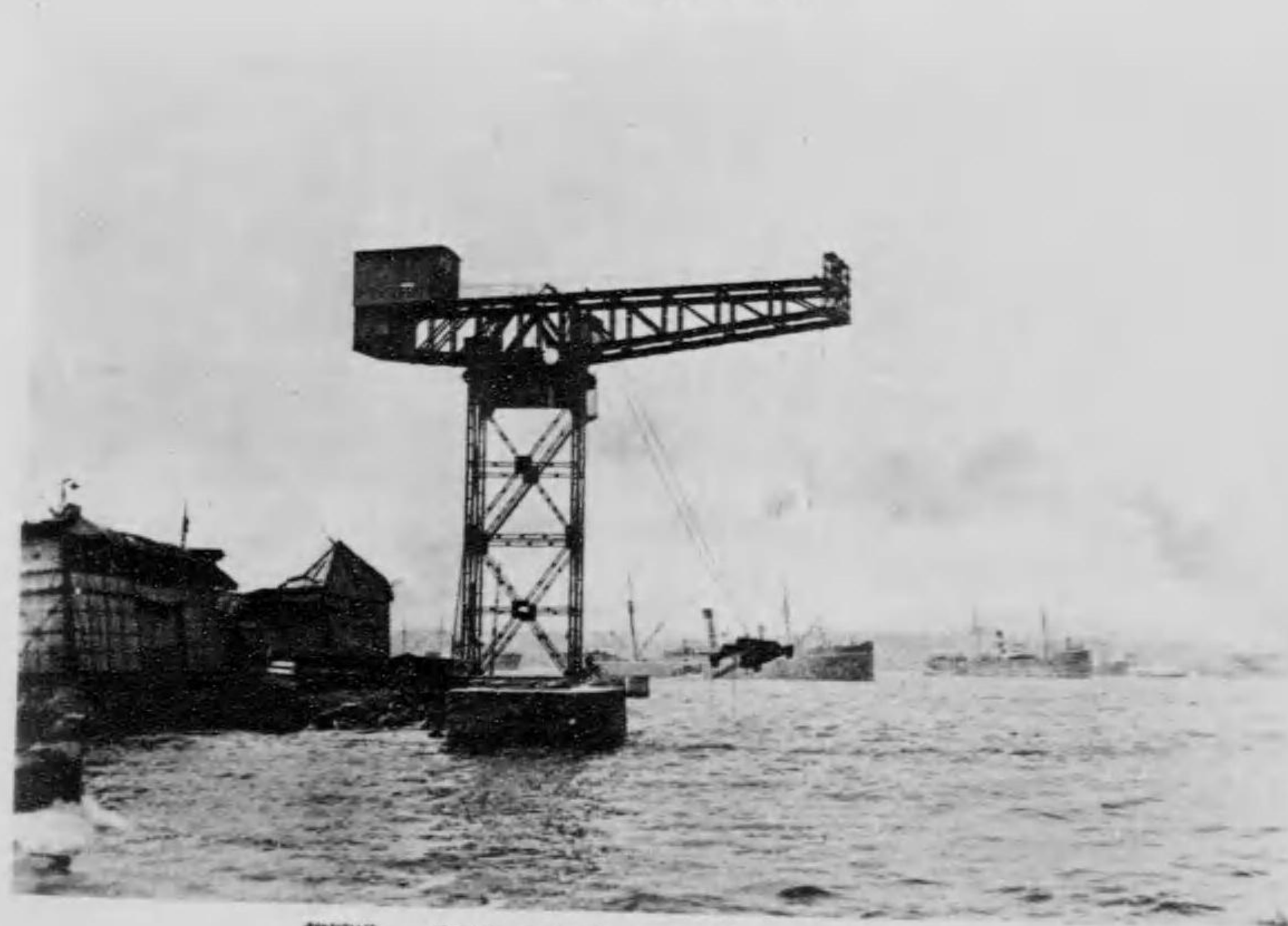
横濱港 突端に無事なる50噸定置起重機
