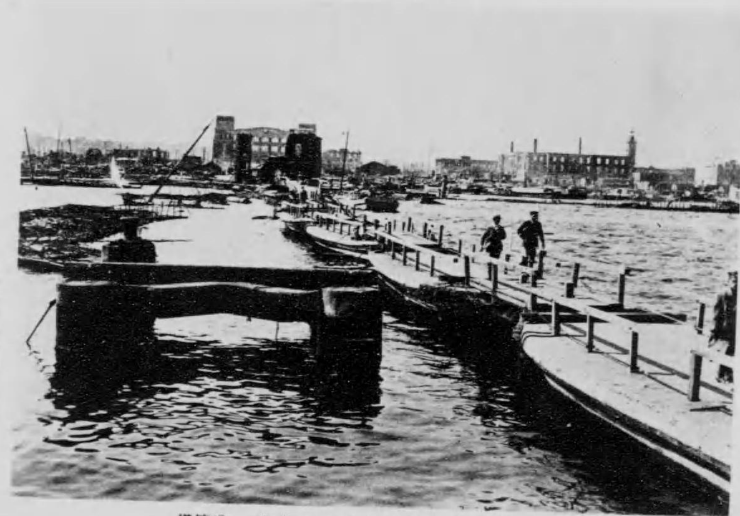
横濱港 残存せる棧橋に聯絡する船棧橋
