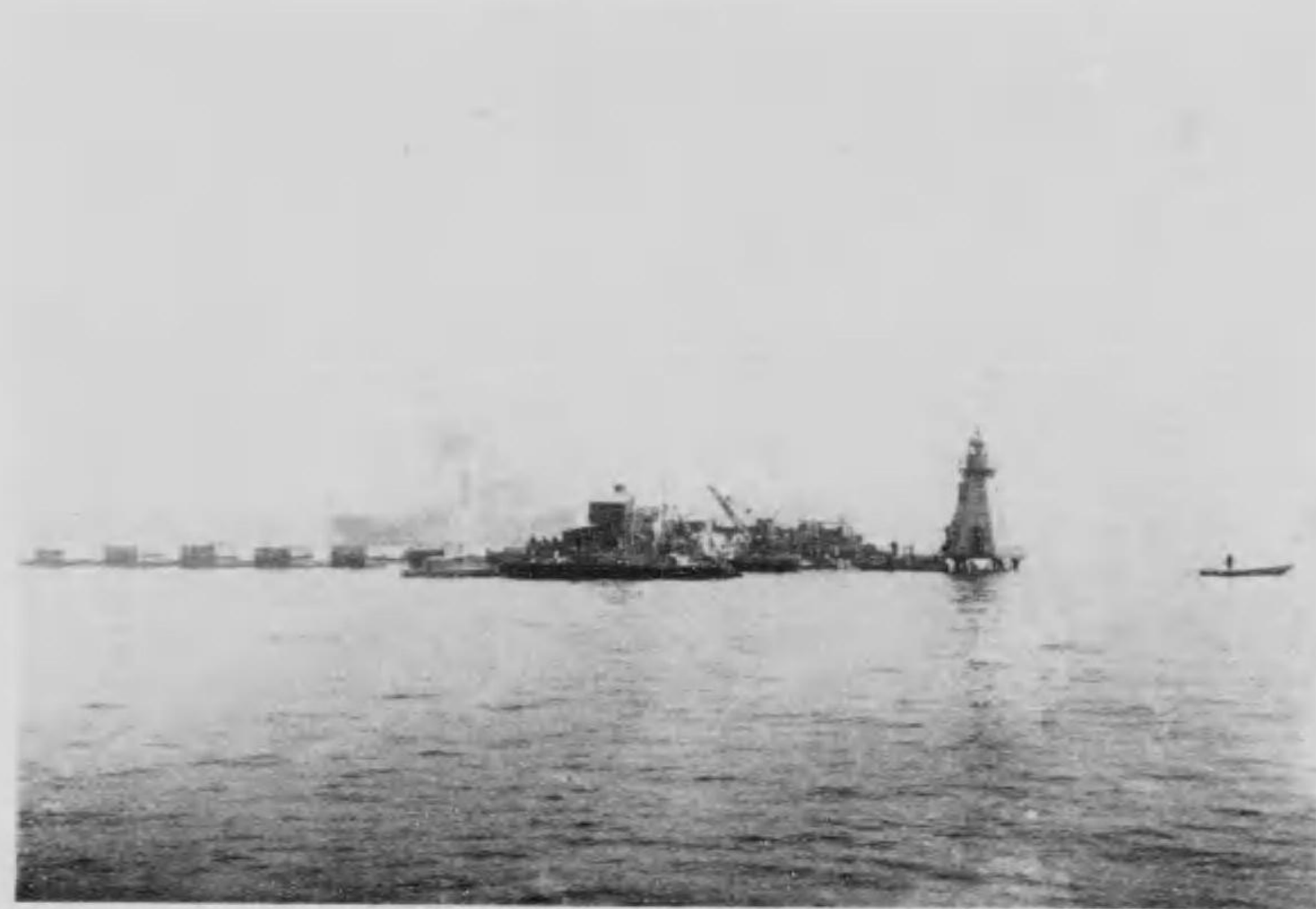
横濱港 震災後の北防波堤燈臺（復舊工事中の防波堤）
