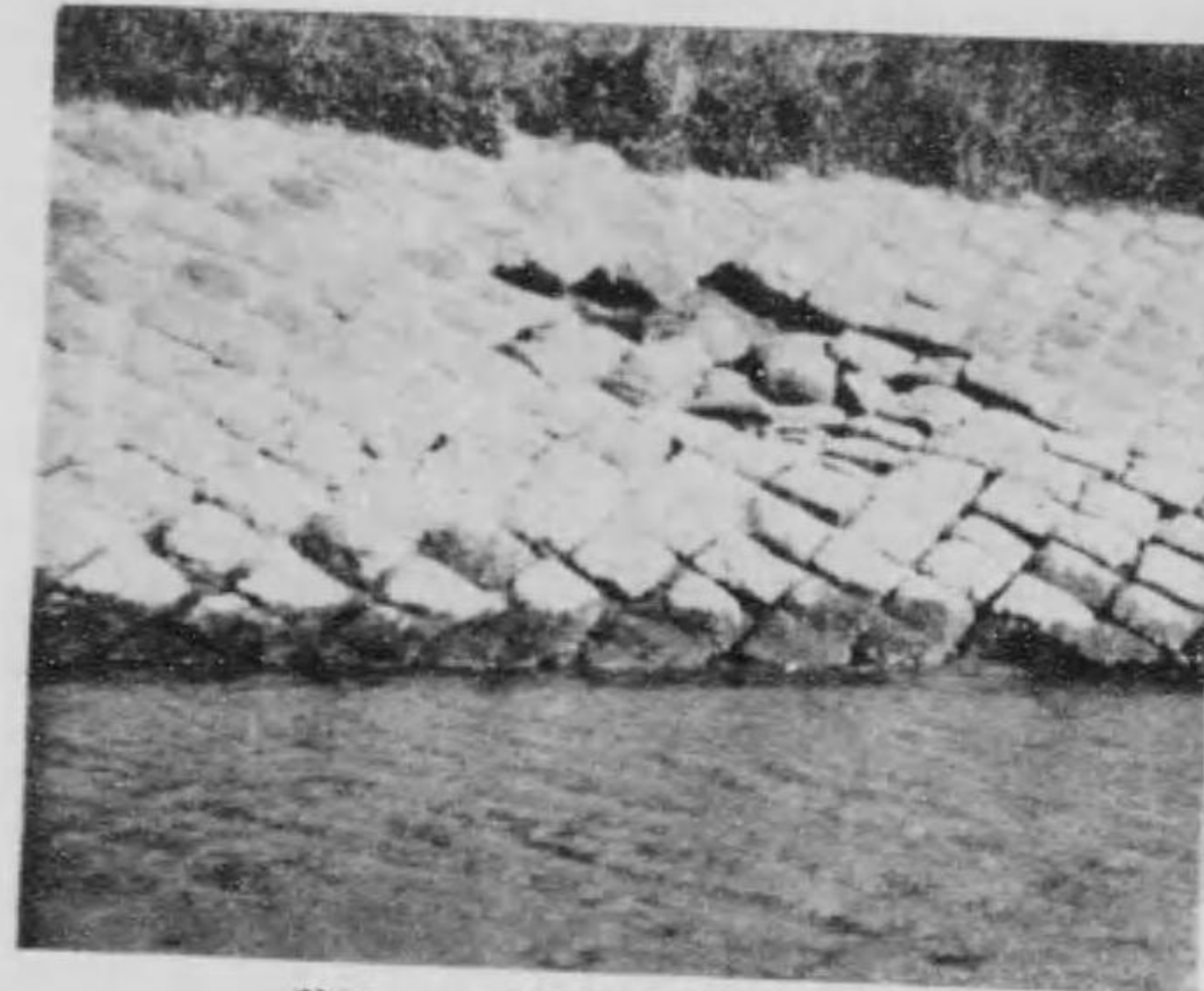
荒川 本所區向島小梅町向島堤防
