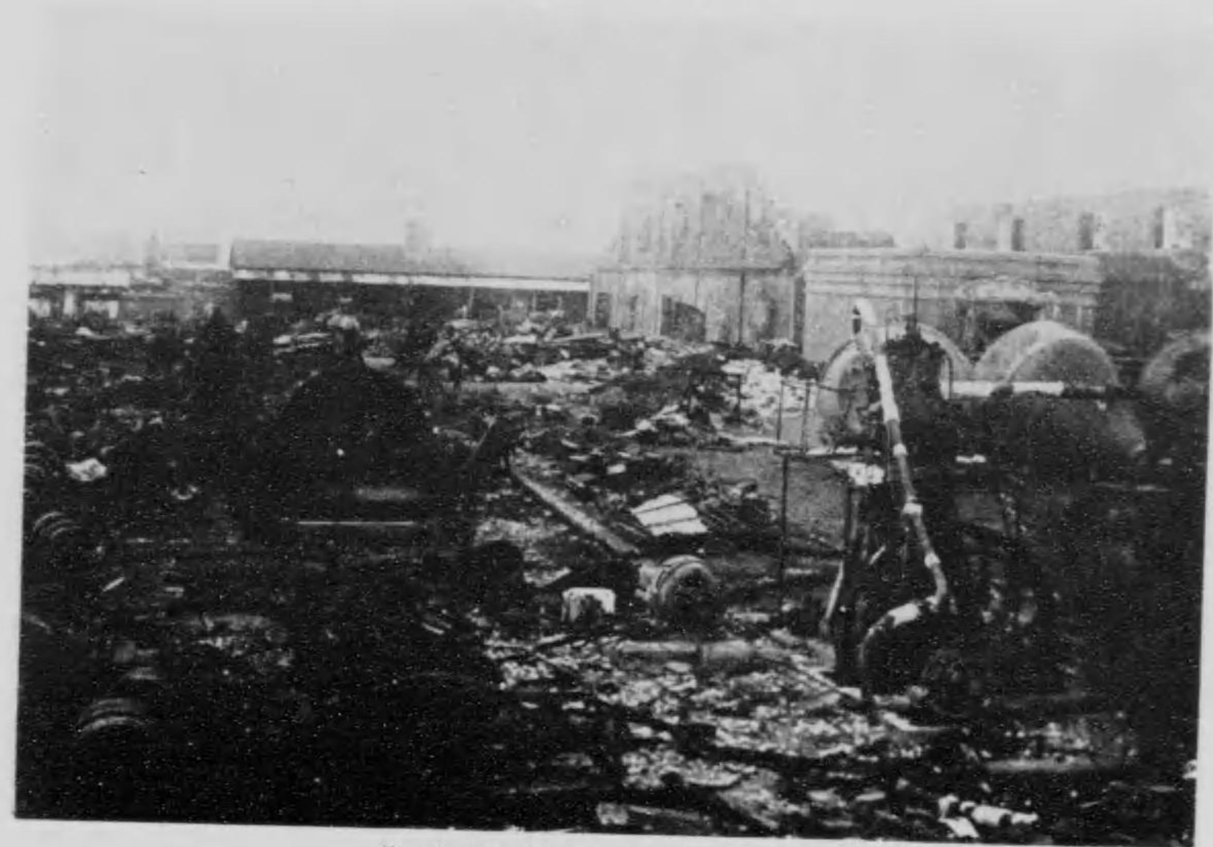
航路標識管理所の被害
