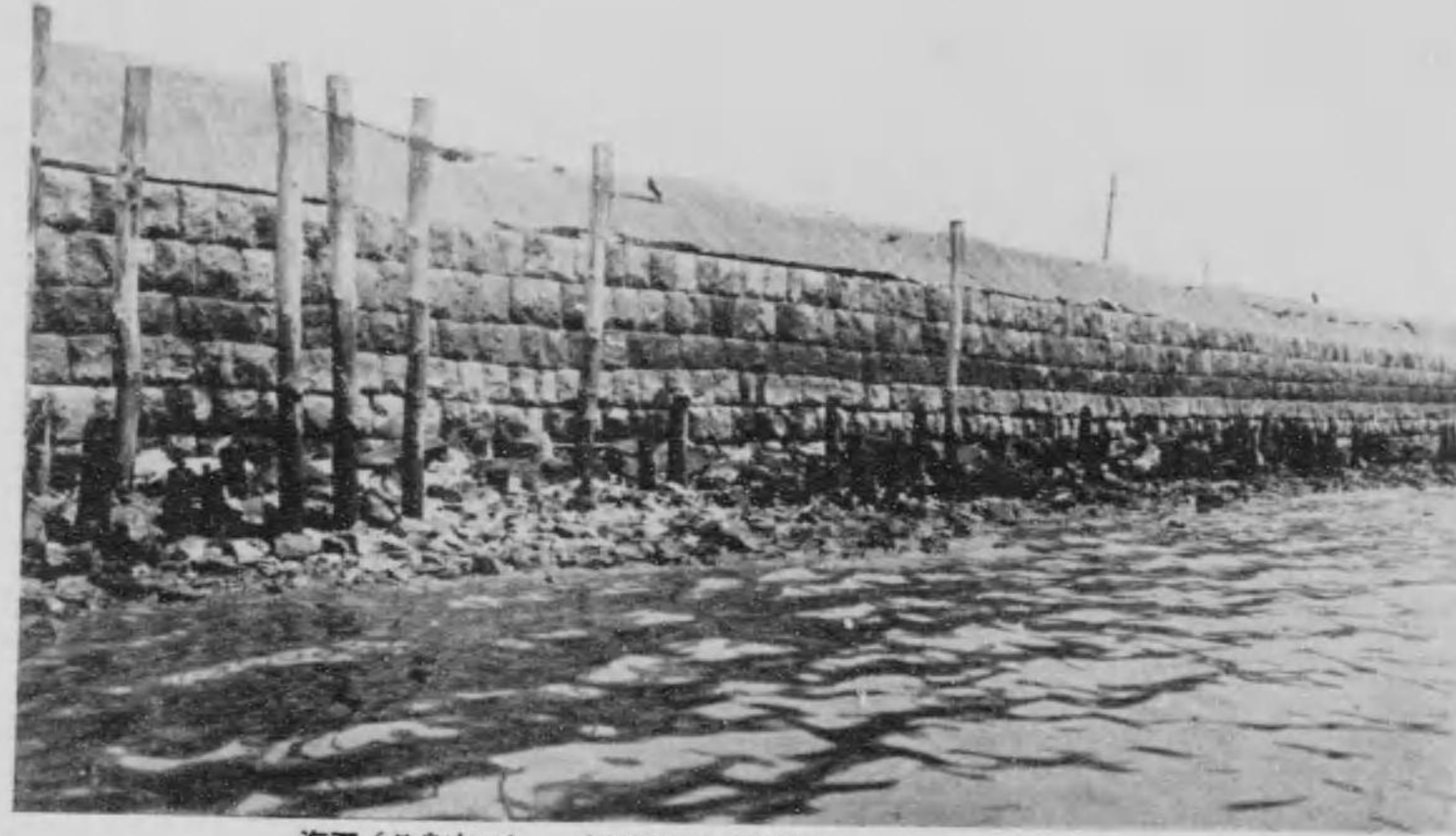
海面(月島方面) 京橋區月島東海岸通七丁目八丁目混凝土堤防
