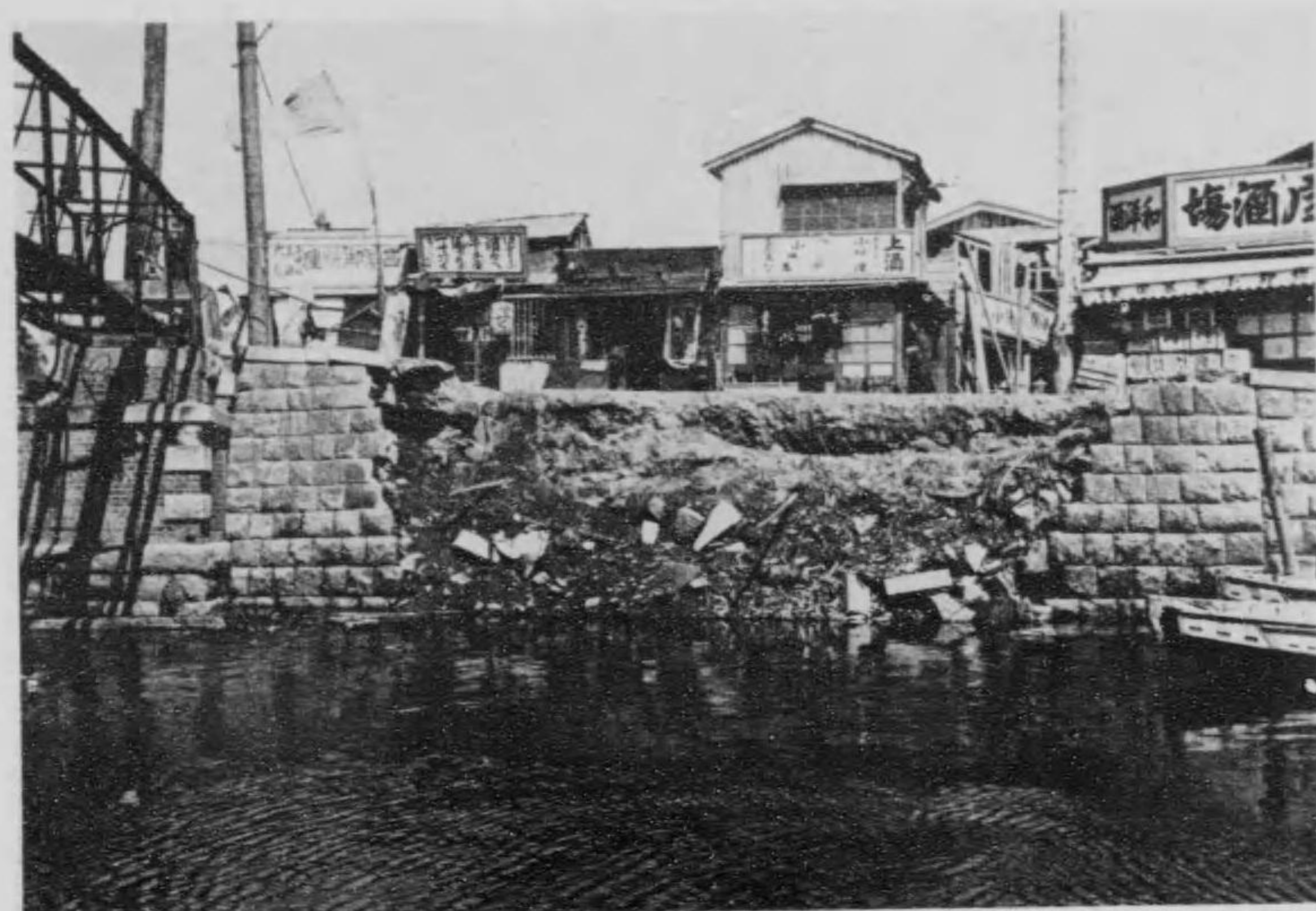
大横川 深川區西平井町澤海橋下流護岸
