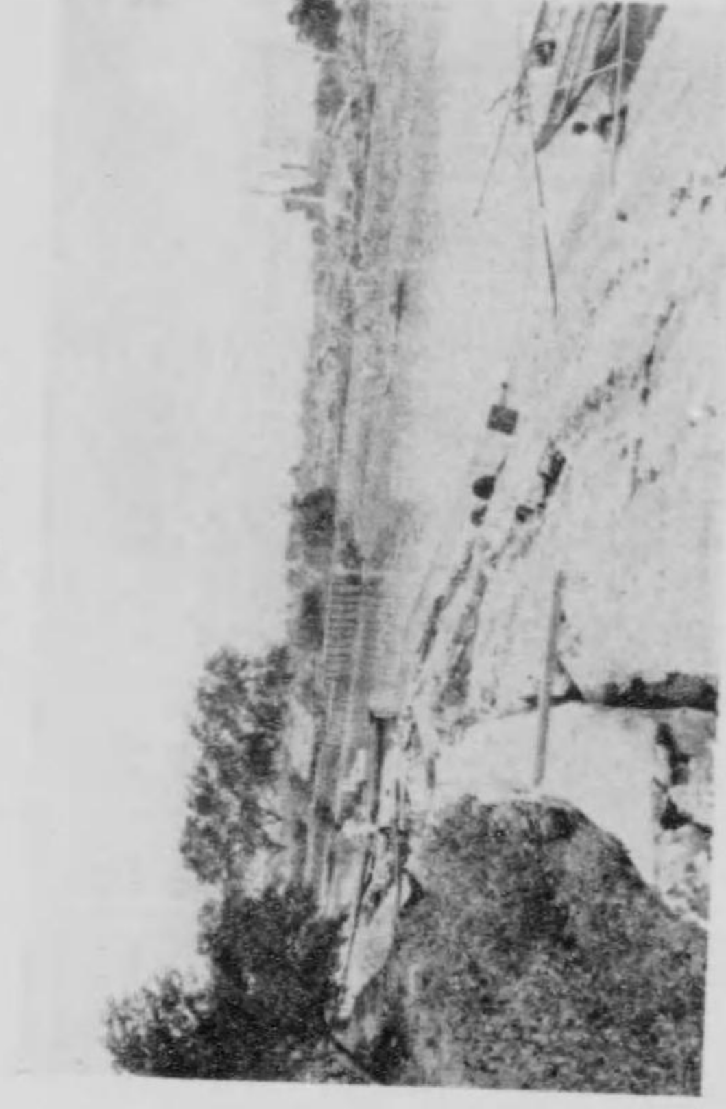
(港灣) 東京府管内海堤工事 東京府往原郡大森町中ノ島海岸堤の震害
