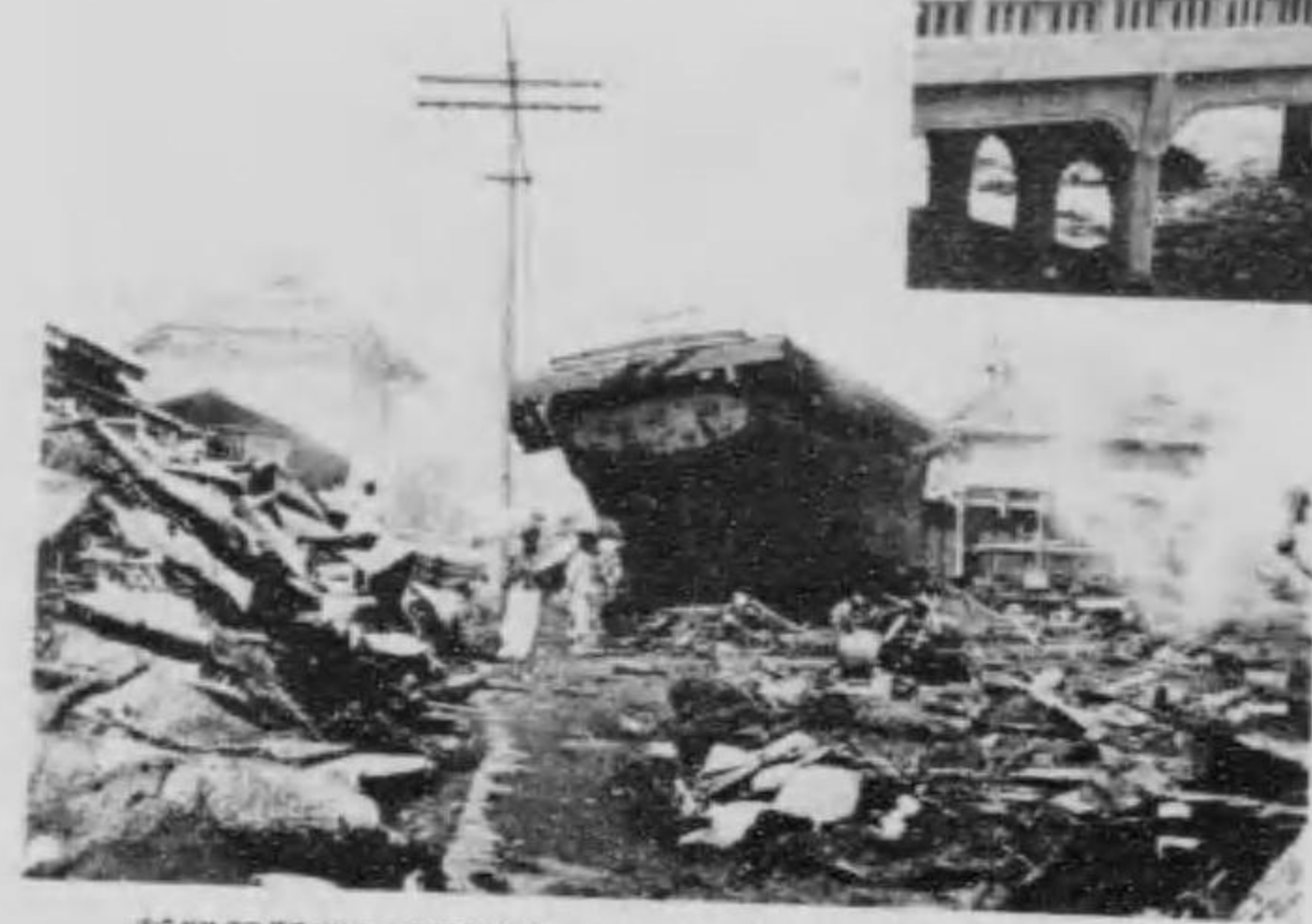
静岡県伊東郡熱海線田方郡伊東町湯川地内津浪のため 縣道上に在る漁船辨天丸
