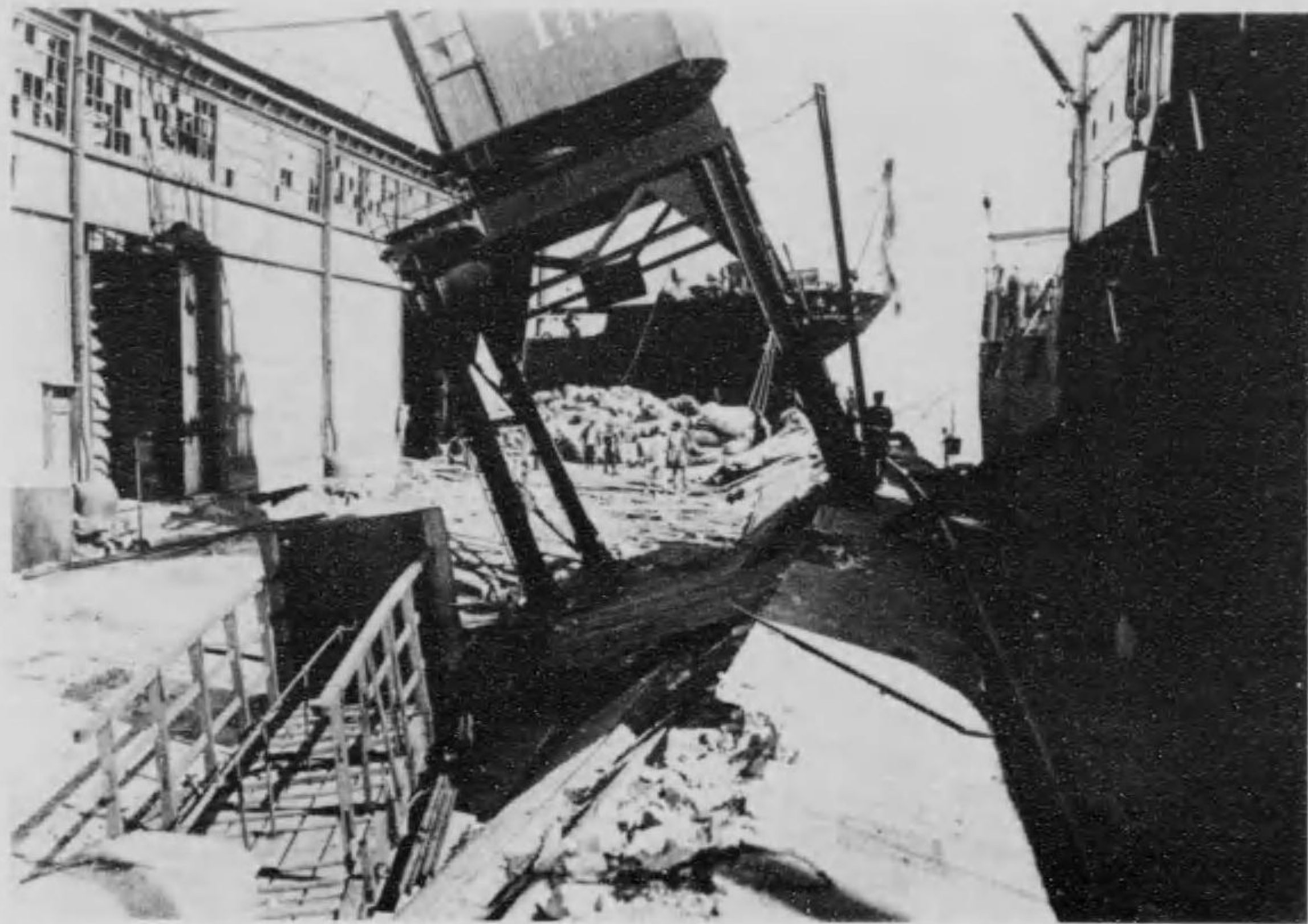
横濱港 残存せる第一號岸壁
