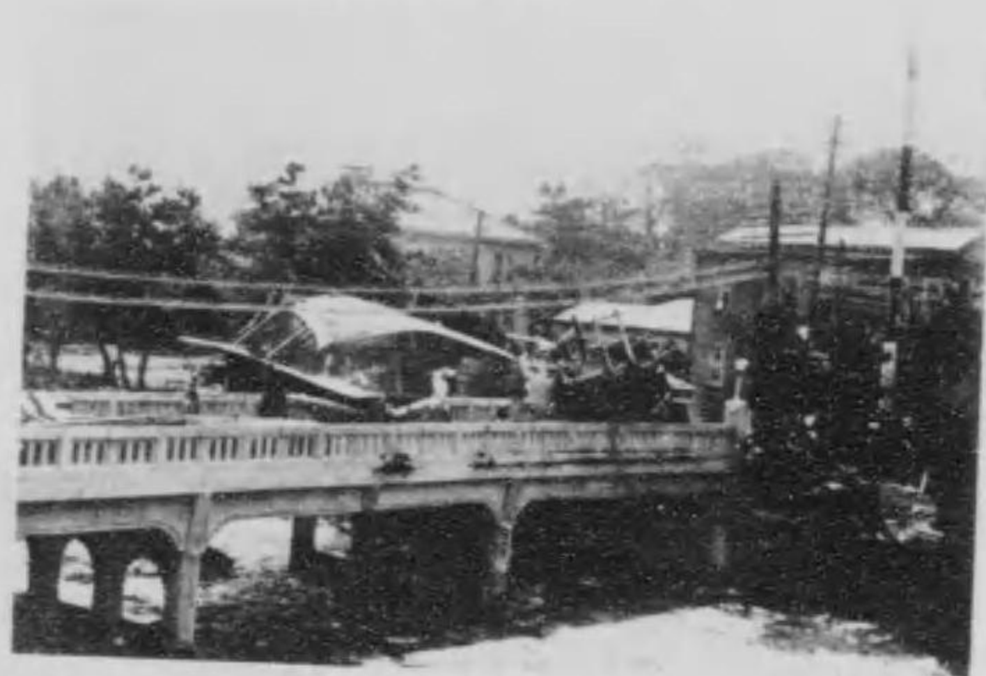
静岡県田方郡伊東町松原大川橋(鐵筋 混成土橋)大正十二年九月一日の地震に 伴ふ津浪のため高欄破壞の有様
