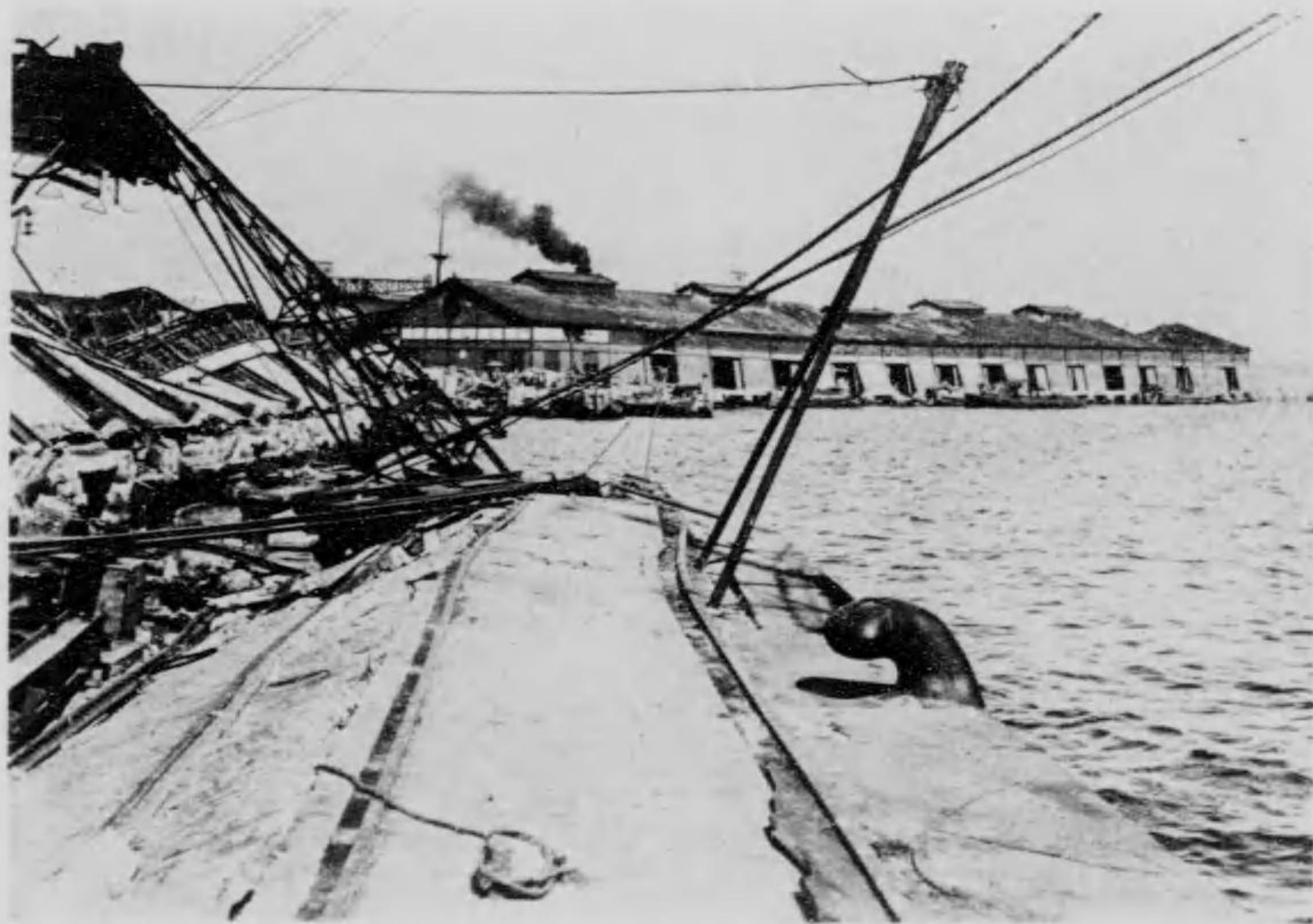
横濱港 残存せる第二號岸壁上より第三號及び第四號岸壁を望む
