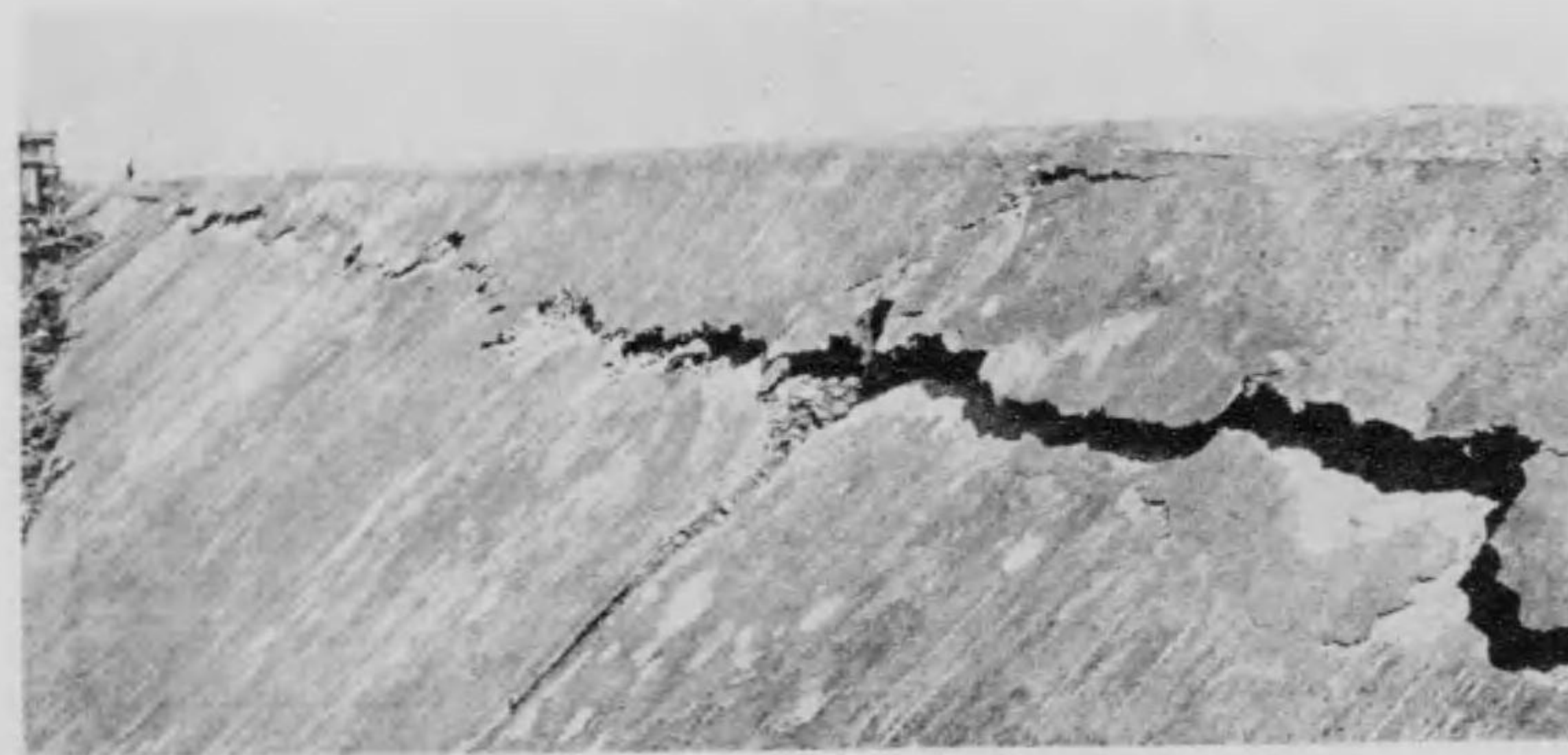
海面 (平久町及洲崎方面) 深川區洲崎辨天町海面堤防(其三)(背面)
