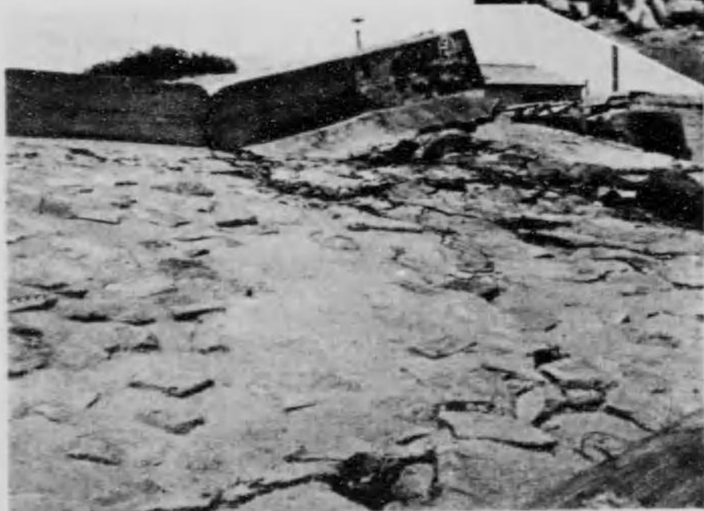
汐濱川 深川區鹽濱町大横川南支川合流點張石防波堤護岸
