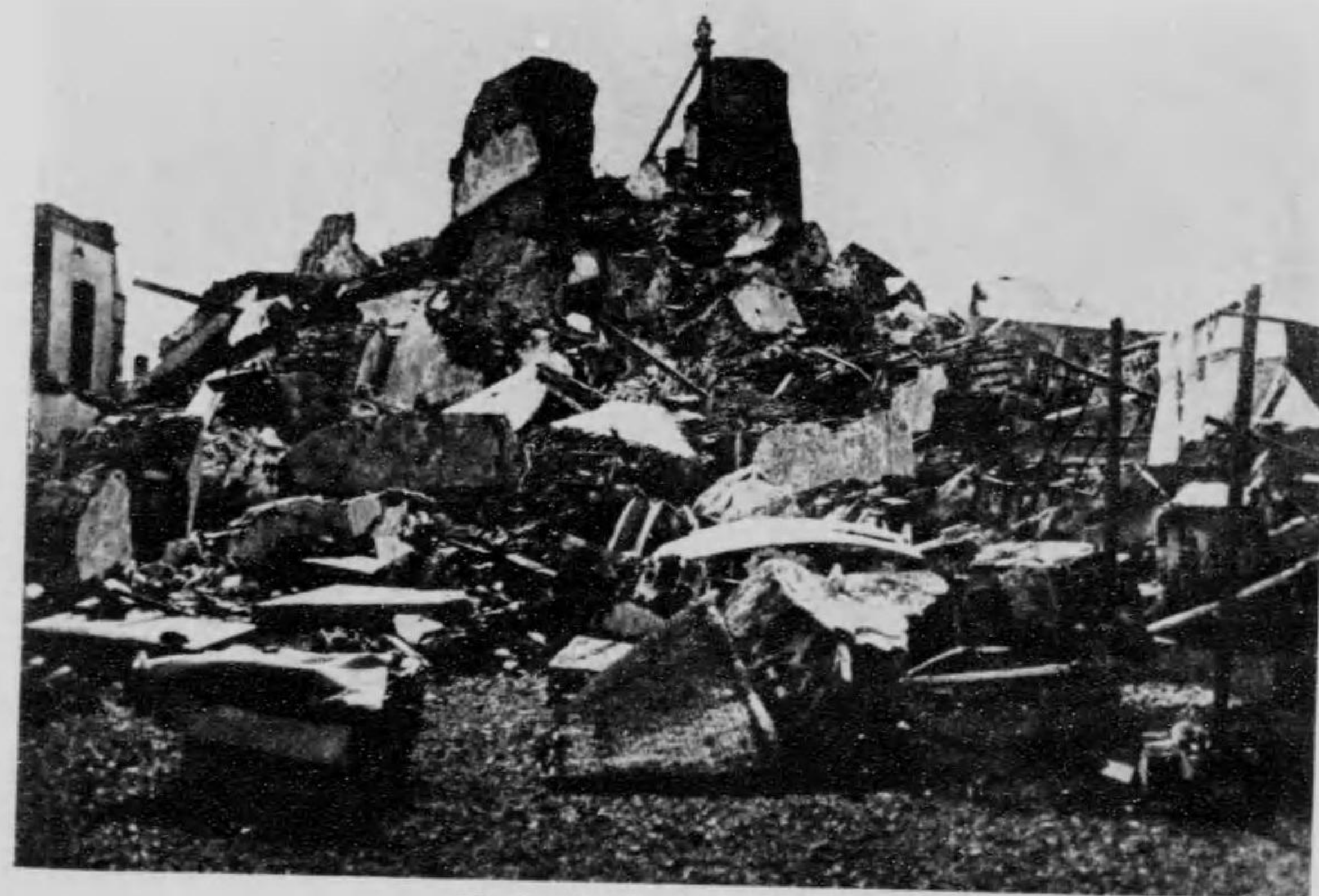
野島埼燈臺の被害
