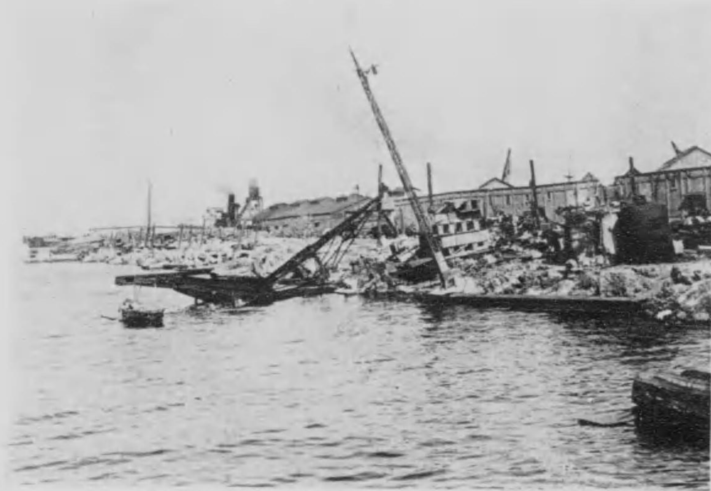
横濱港 第十二號及び第十三號岸壁の破壊
