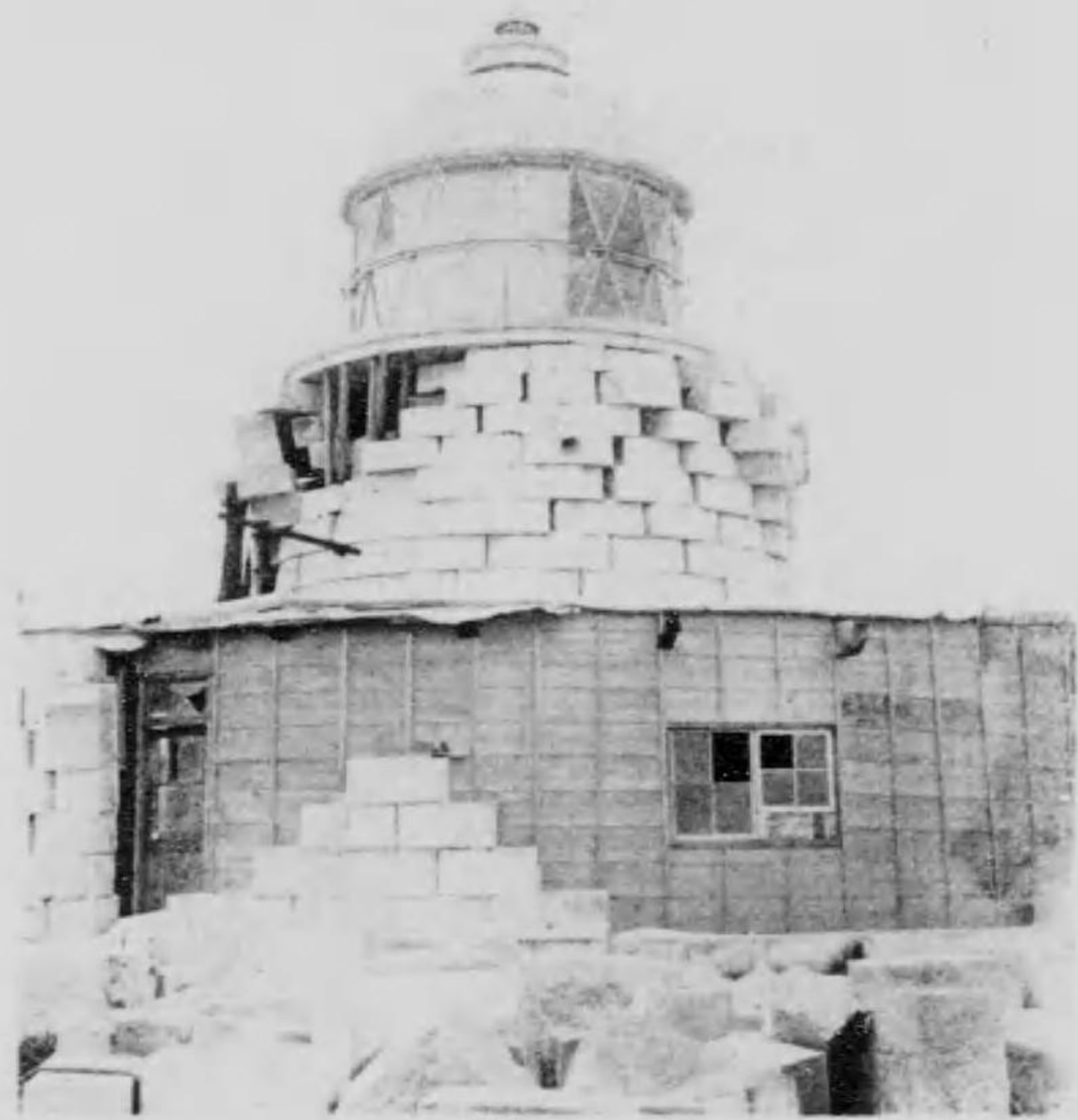
劍埼燈臺の被害
