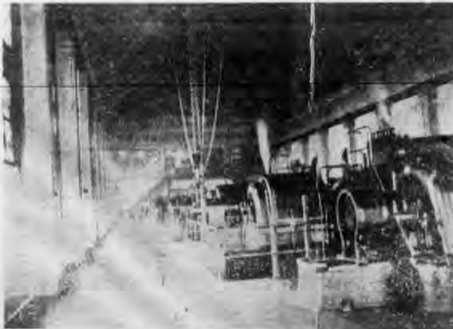
撫順第二發電所電機室
