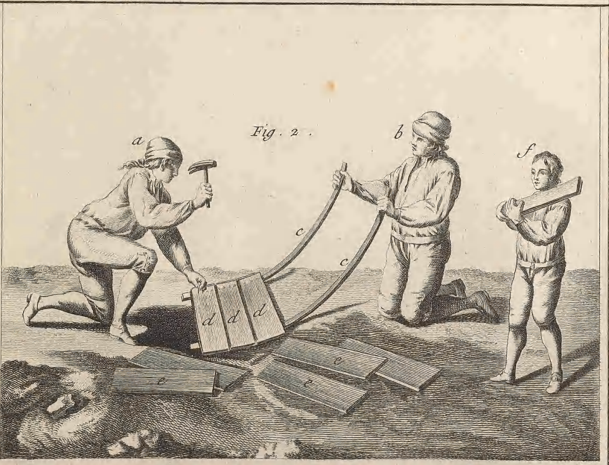
Verrerie en bois, l'opération de raccomoder le Banc du Four, et construction du Bonhomme qui sert à soutenir le petit mur de terre glaise qui ferme le Four.
