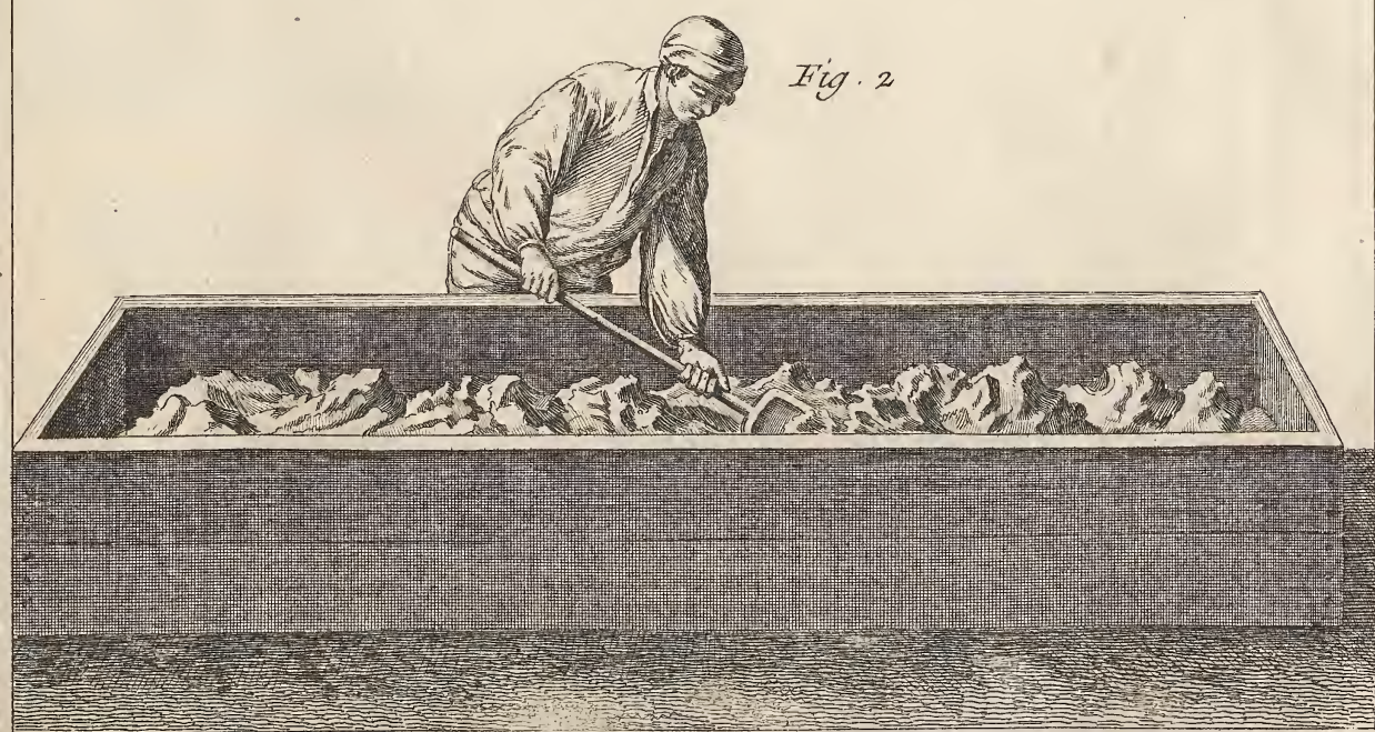
Radel Del. Benard Peint. Verrerie en bois, l'opération de Piler dans une auge de bois de la terre glaise seche pour la formation des Briques et des Pots, et l'opération de l'Humecter et de la mêler de pilures d'anciens pots pour la corriger.
