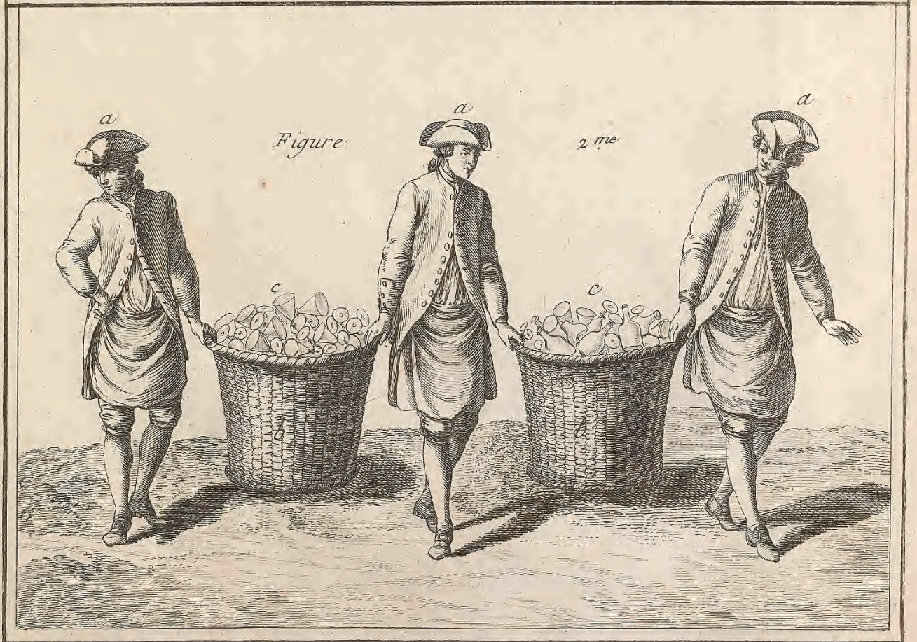
Verrerie en bois, l'opération de retirer de l'Arche les Ferraces remplies de différentes Marchandises de Verrerie pour les porter au magasin
