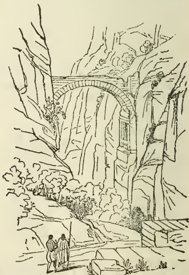
177. Bridge at El Sek.
