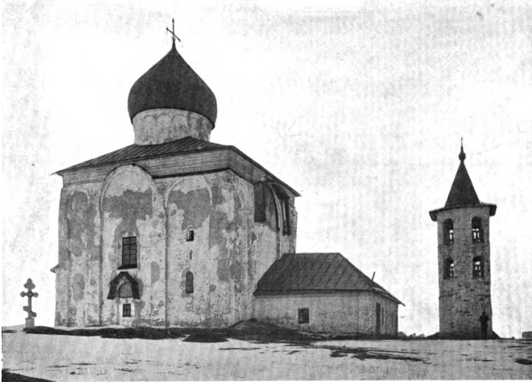
Съверный фасадъ до ремонта (мартъ 1903).
