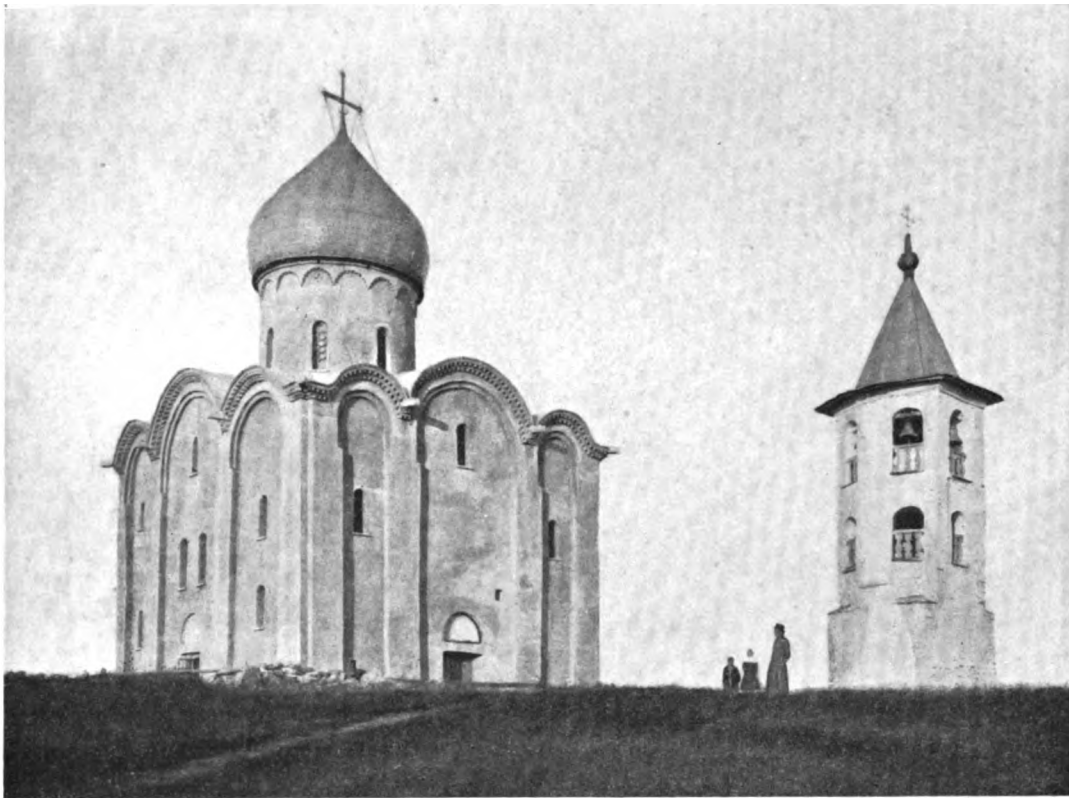
Видъ съ сѣверо-западной стороны послѣ ремонта.
