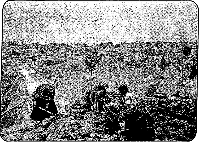
नाँगलदासा में चौखण्डी वाला एनिकट के निर्माण में लगे ग्रामीण
