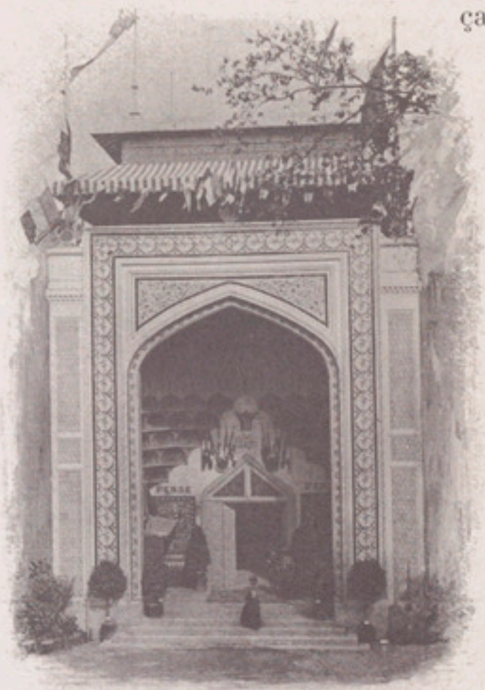
LA GRANDE PORTE DU PAVILLON, RUE DES NATIONS.
