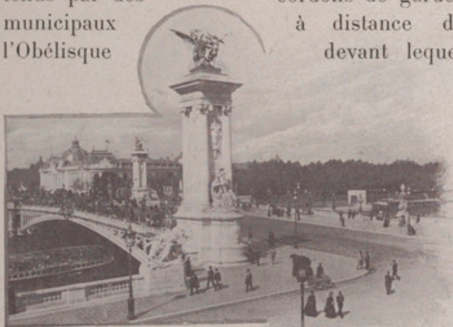
LE PONT ALEXANDRE III.
