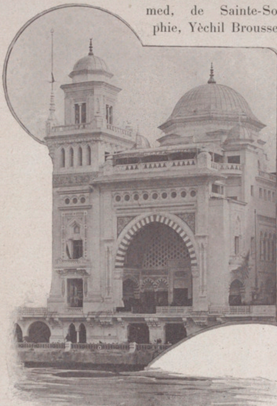
LE PAVILLON OFFICIEL, RUE DES NATIONS.
