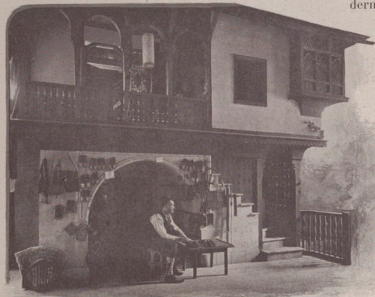
PREMIER ÉTAGE DU PAVILLON : ÉCHOPPE INDIGÈNE.
