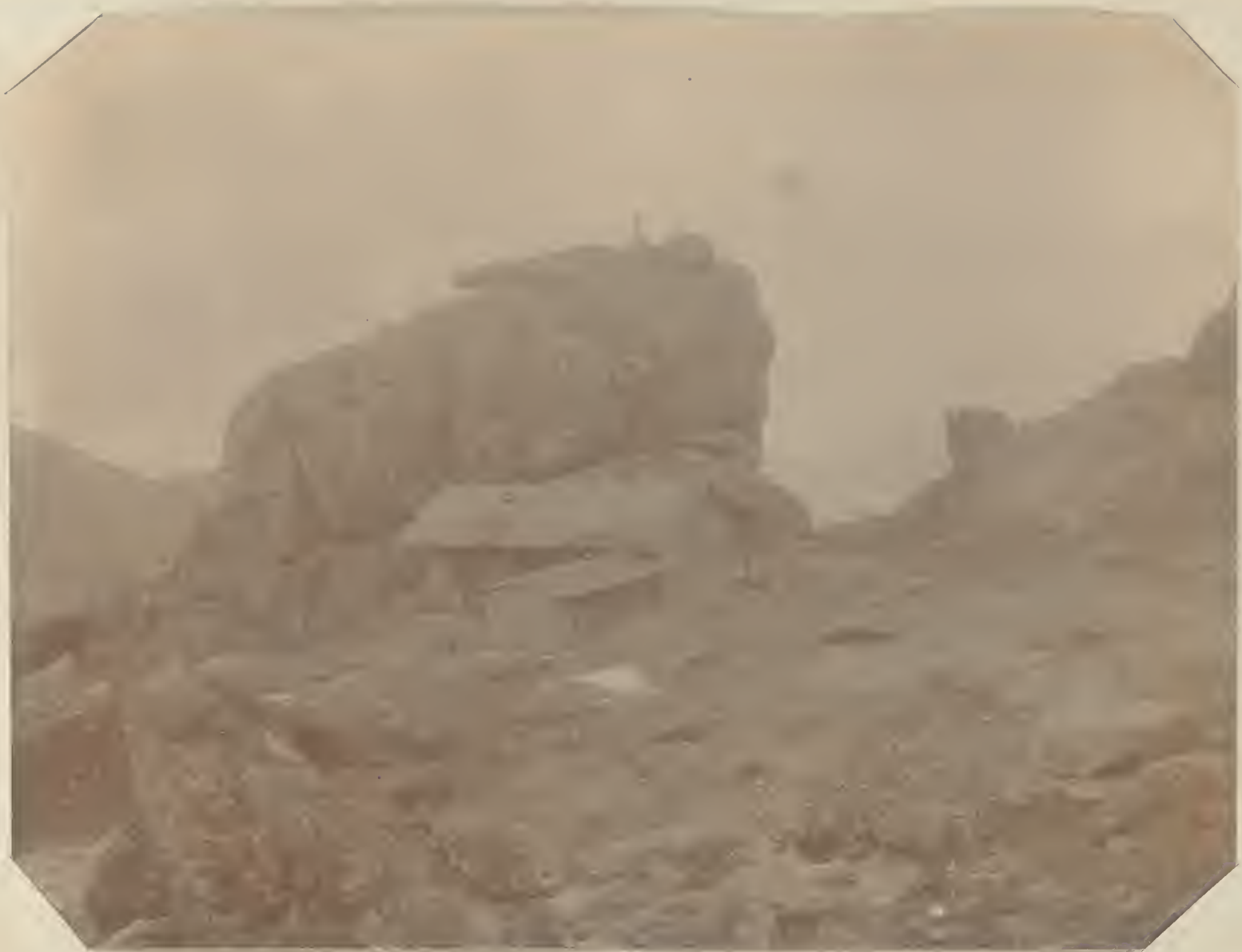
Ernebaude am Bismarckfelsen im Lauschan bei Tsingtan
