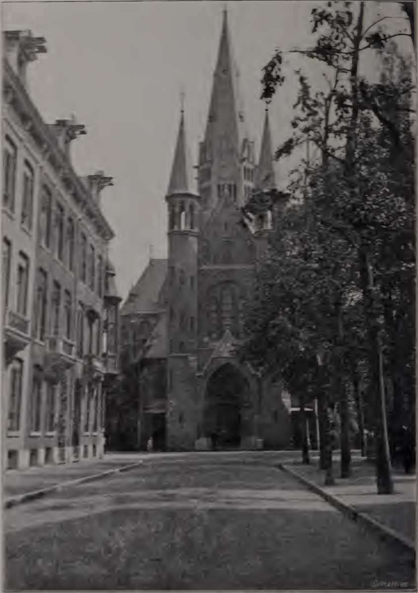
KERK VAN HET H. HART IN DE VONDELSTRAAT TE AMSTERDAM AAN DE WESTZIJDE (NA DEN BRAND VAN 8 NOVEMBER 1904) MDCCCLXX MDCCCCV
