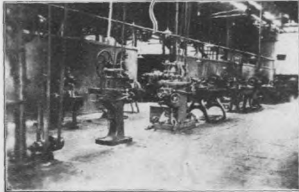
本廠第二機器間之內容
