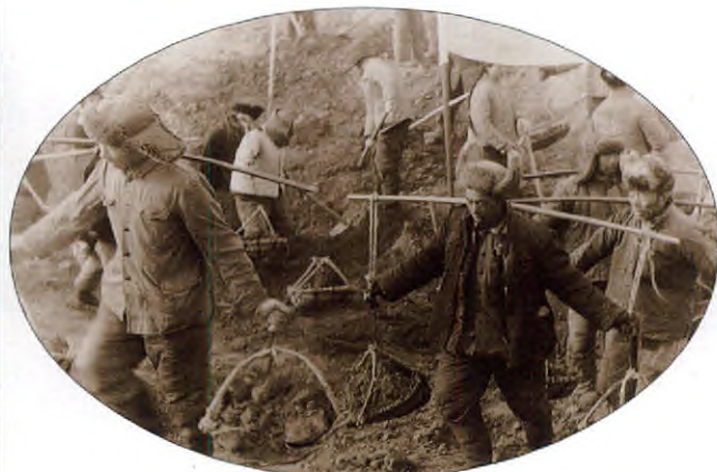
修筑额敏水库（1962年）
