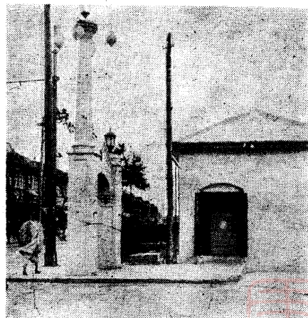
圖十 (圖) 新修之路警駐所
