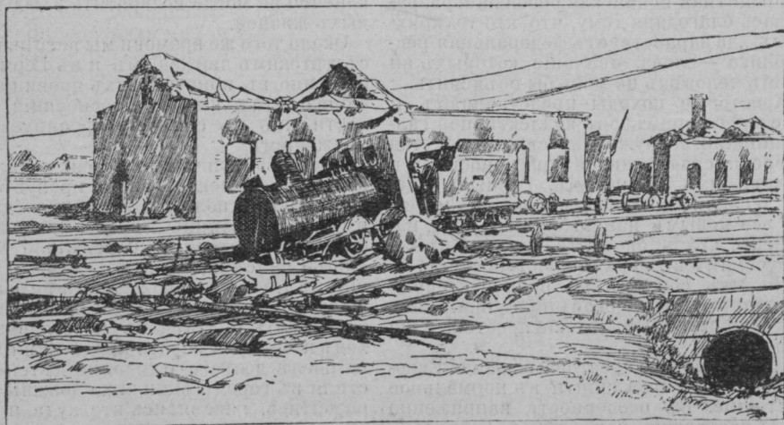
Разрушенная Большими Кулаками станція Хайларъ восточно-китайской ж. д.
