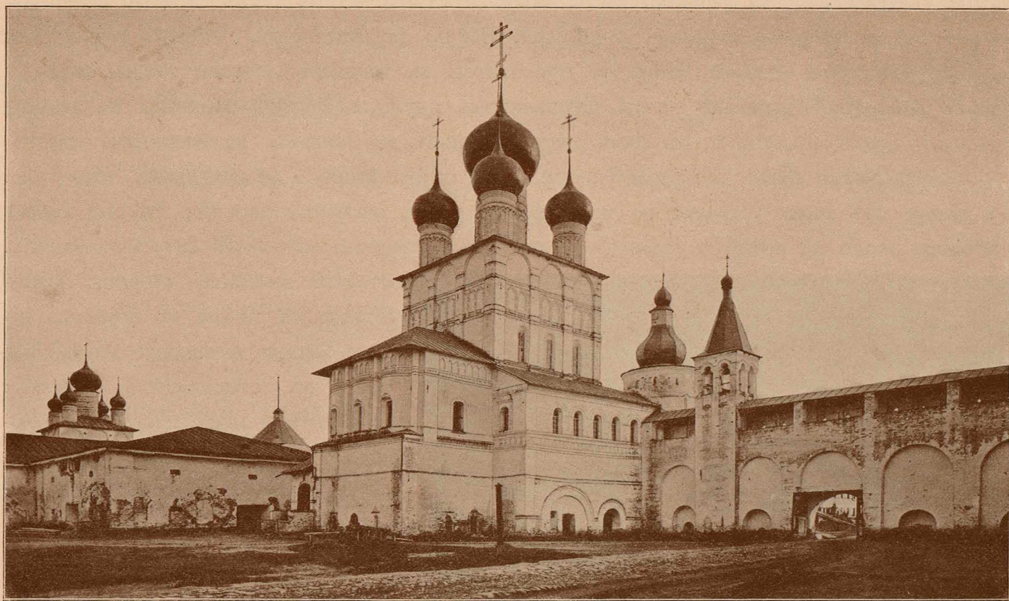
Сѣверо-восточный видъ церкви Иоанна Богослова.
