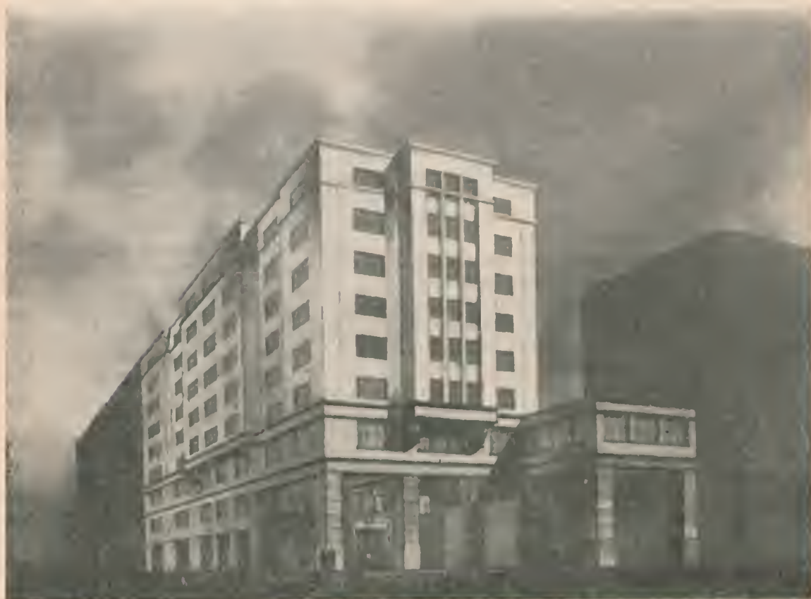
"Casa da Agricultura" — futura sede da Sociedade Nacional de Agricultura, em início de construção
