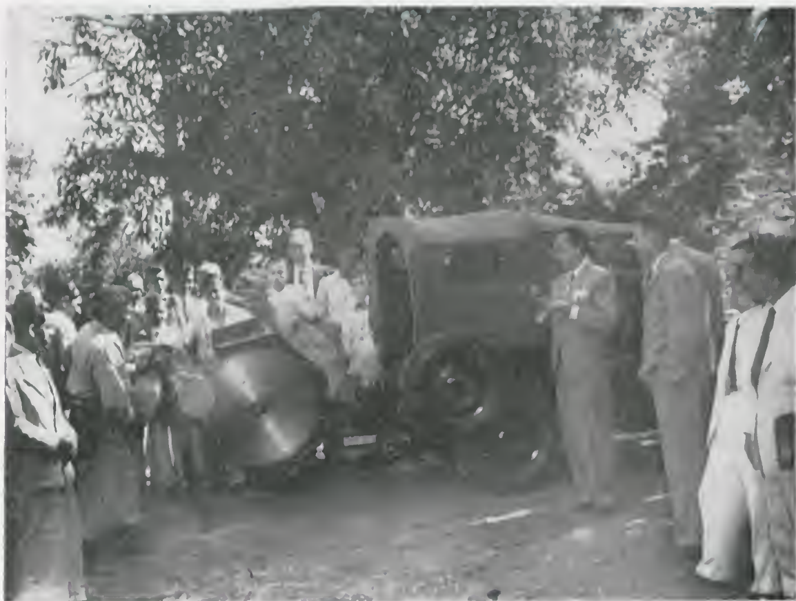
Na Escola de Horticultura Wencesláo Belló: um Jeep agrícola, ao que foi adaptada uma serra de disco, funcionando, à vista de alunos e interessados.
