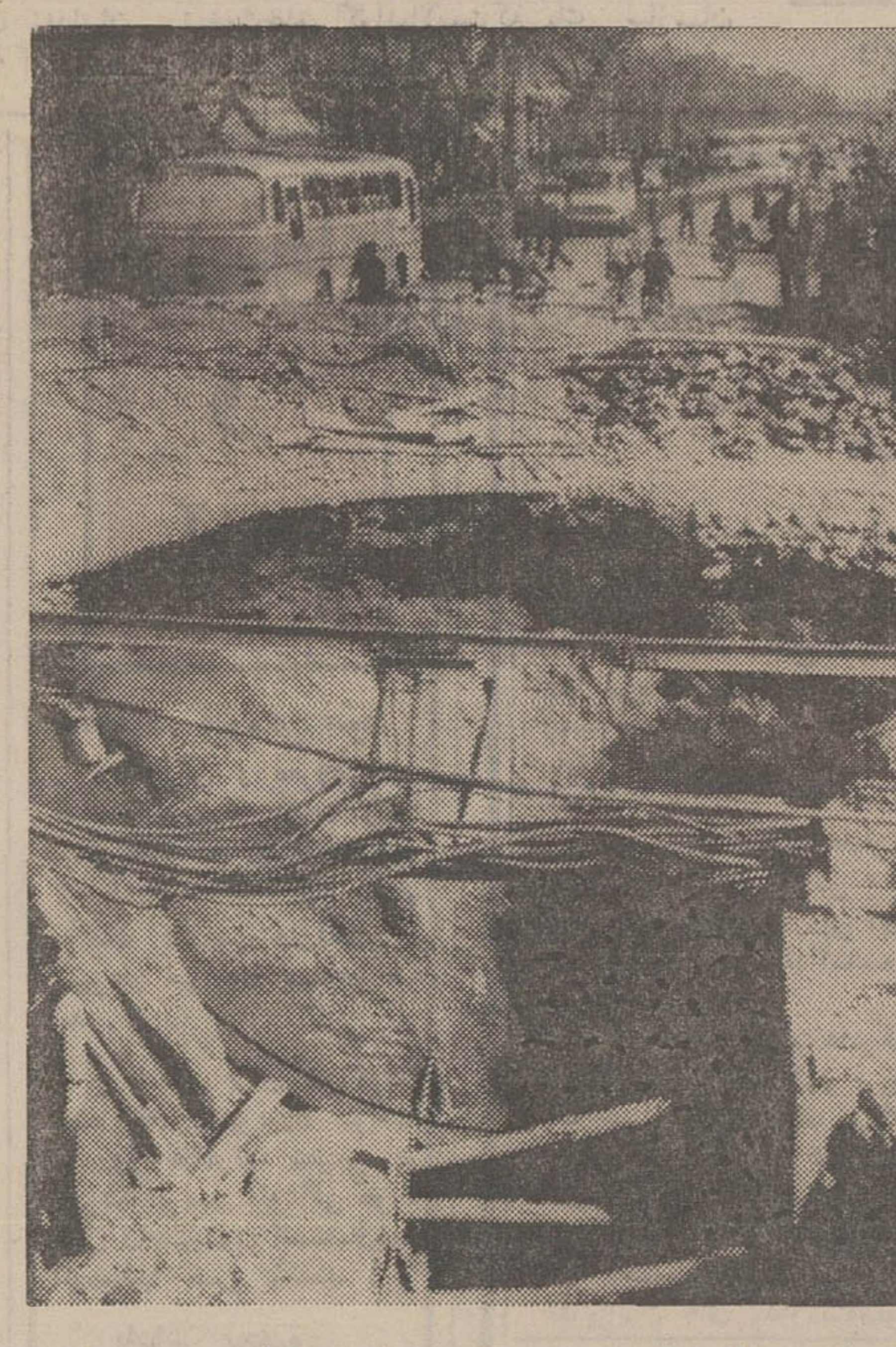
در عکس بالا قسمت فرونشسته میدان سید اسمعیل دیده میشود ماموران مشغول ستون بندی و ترمیم خرابی هستند.
