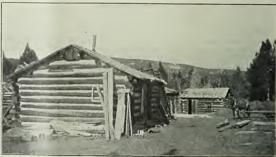
Abb. 3. Älteste Bergmannshütte in Lake County.
