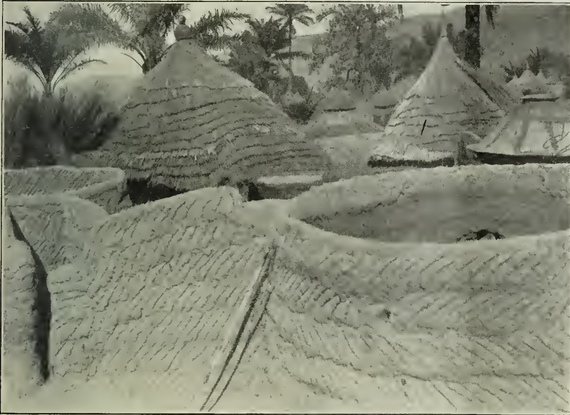
Abb. 13. Difale-Gehöft im Bau.
