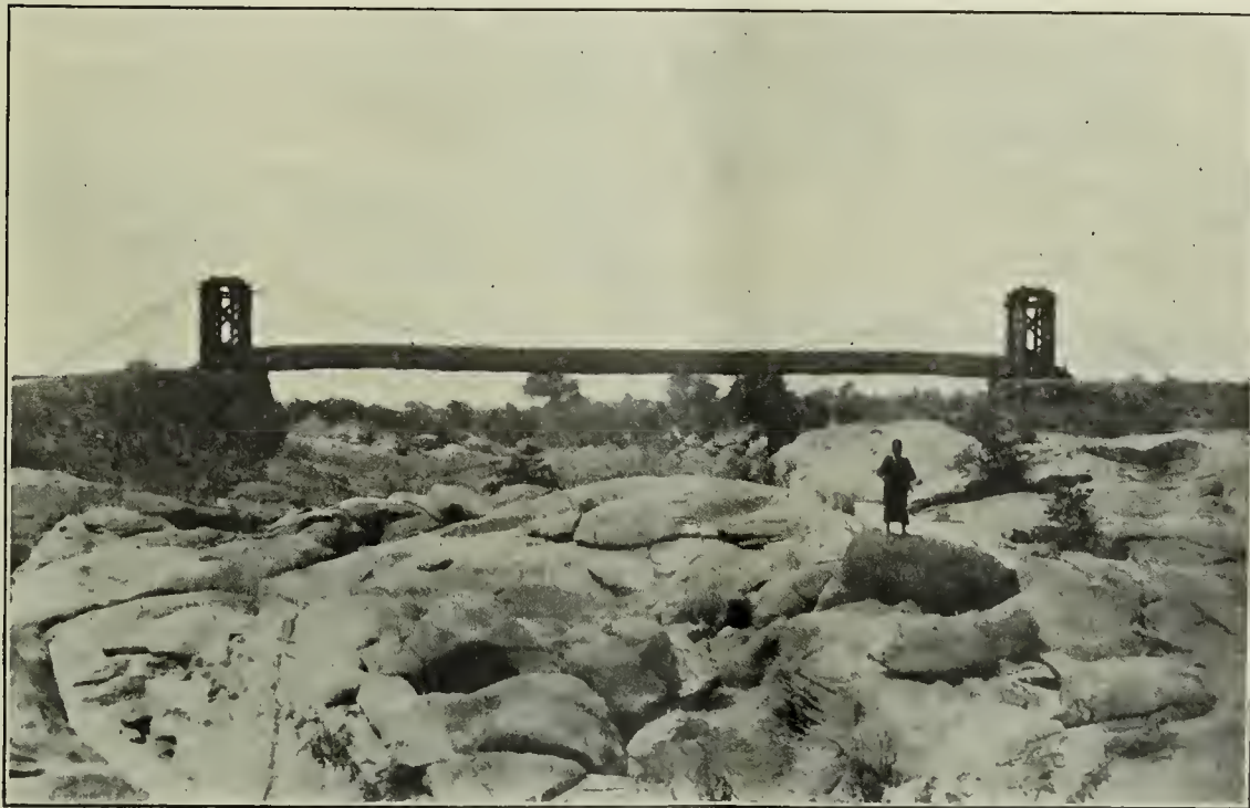
Abb. 1. Drahtseilbrücke über den Kará.
