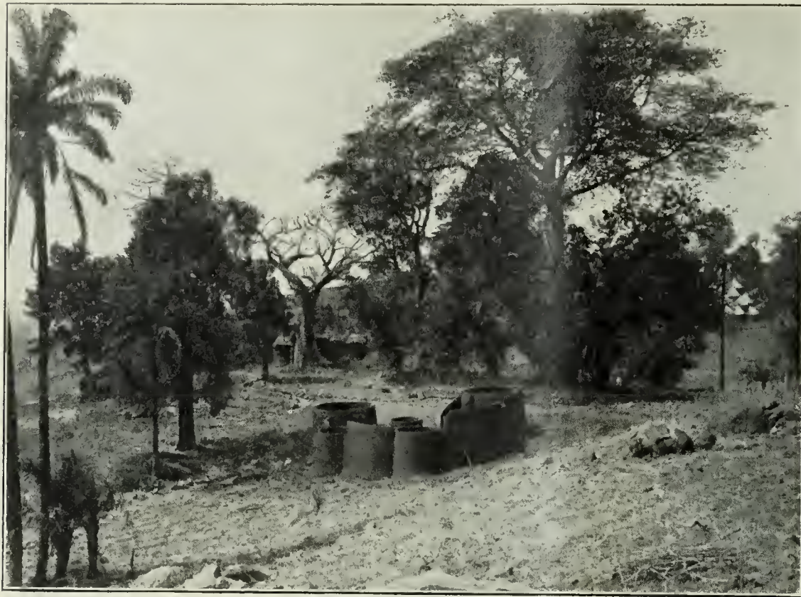
Abb. 7. Kábure-Gehöft im Bau.
