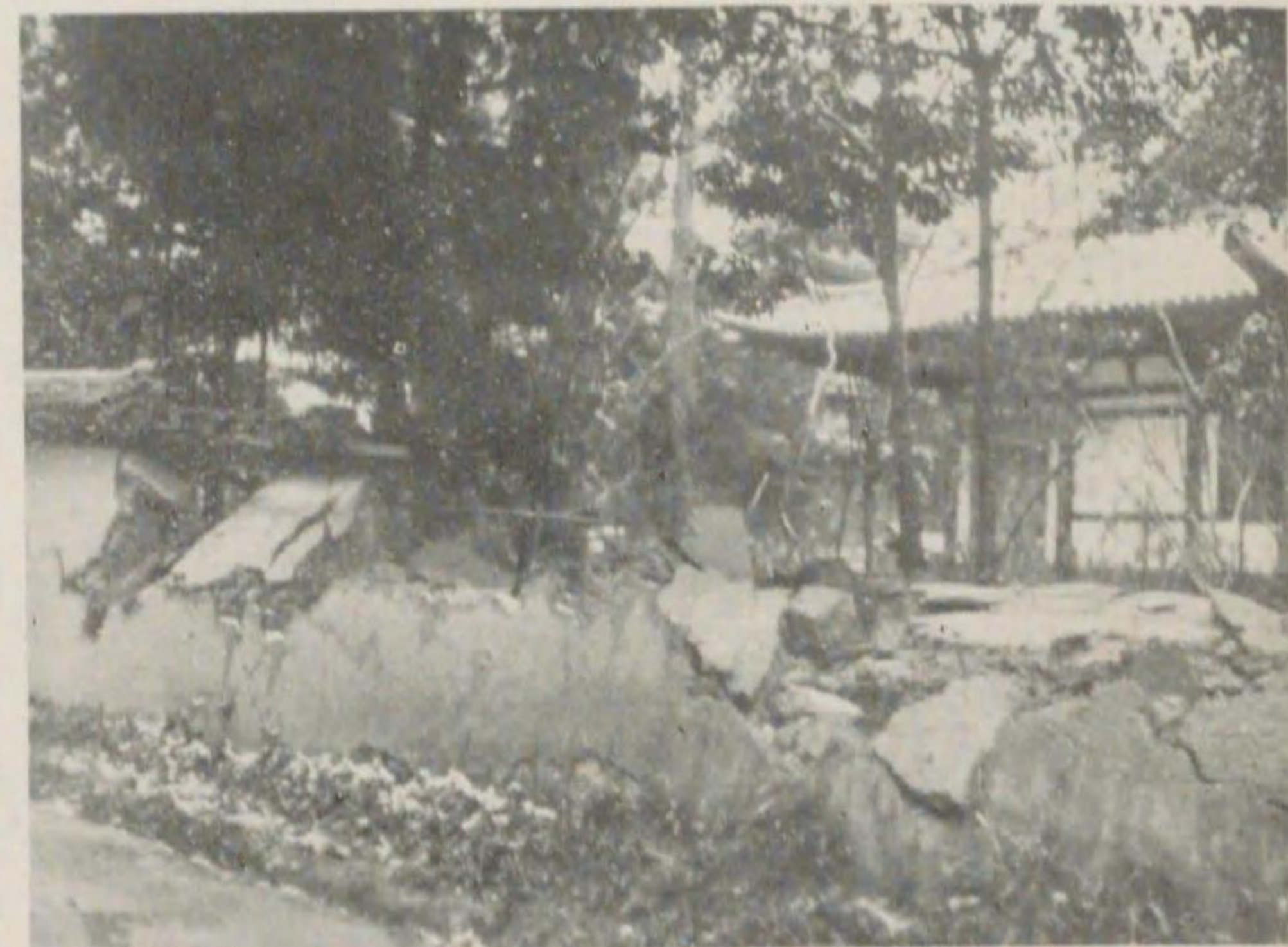
2) 奈良縣生駒郡都跡村西ノ京藥師寺の土塀の崩壞(塀の厚さ約45厘高さ約2米)
