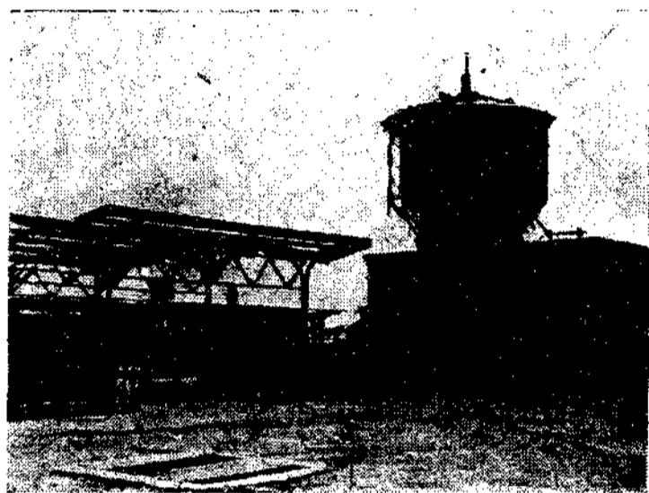
最後之四平車站，僅餘鋼筋空架。
