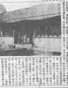
某政府機關之建築。
